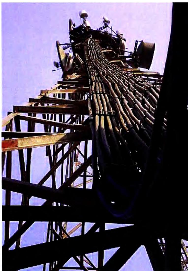
Figura 3.10. Saturación de cables alimentadores.
