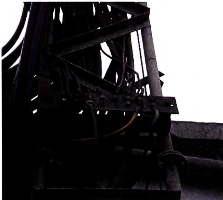
Figura 3.12. Saturación de cables alimentadores.
