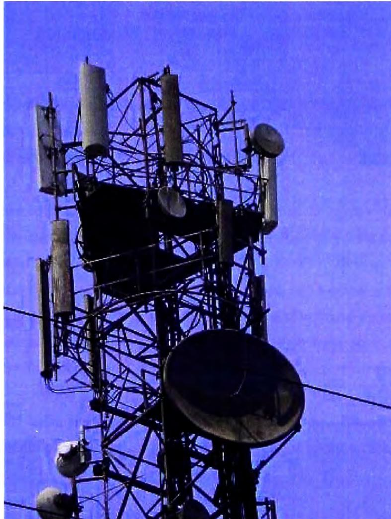
Figura 2.7. Distribución de antenas en torre auto soportada.
