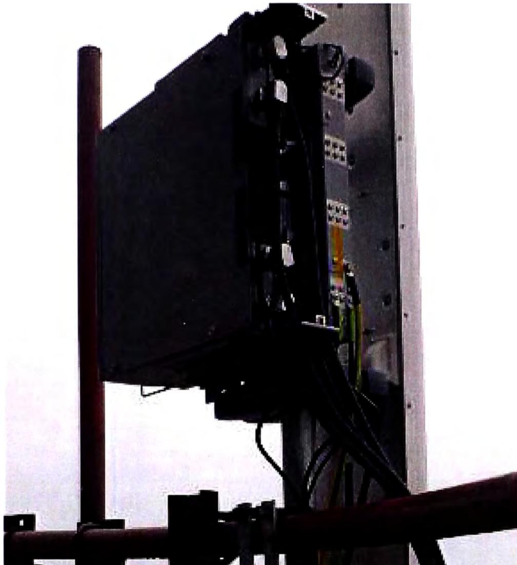
Figura 3.4. RF Module dual.
