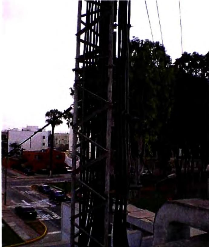
Figura 3.11. Saturación de cables alimentadores.
