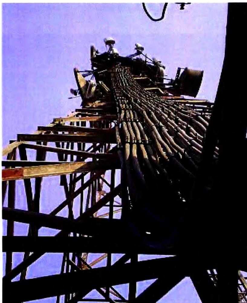
Figura 2.5. Saturación de cables alimentadores.
