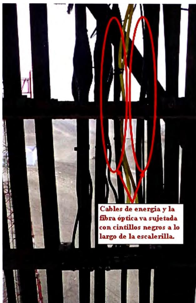
Figura 3.16. Recorrido de cables de energía y F.O
