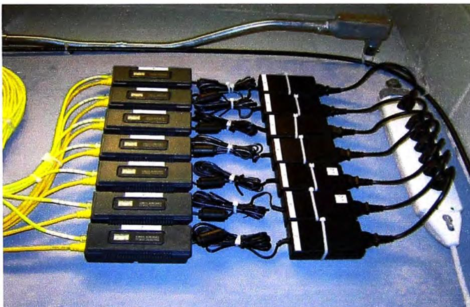
**Figura A.2** Inyectores de corriente (POWER INJECTORS)
