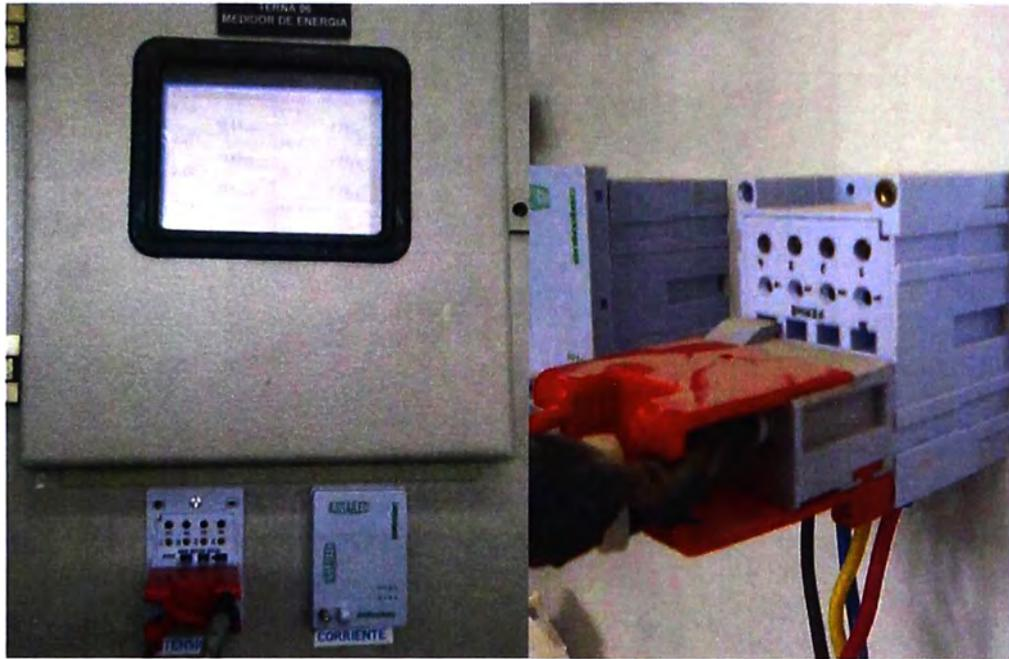
**Fig. 2.3 Borneras de Prueba marca Entretec de Tensión.**
