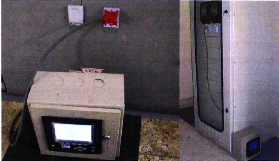
**Fig. 2.11 Equipo Registrador Fijo-Portátil marca Power Measurement ION7600.**
