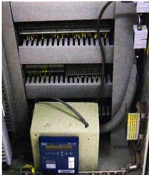
**Fig. 2.12 Equipo Registrador Fijo-Portátil Marca SEL Modelo 734P.**
