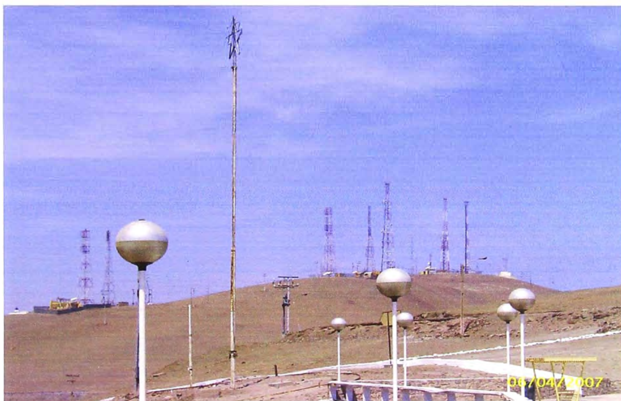
Figura 6.44.- Vista superior del Morro de Arica, se observa antenas de distintos servicios de telecomunicaciones.
