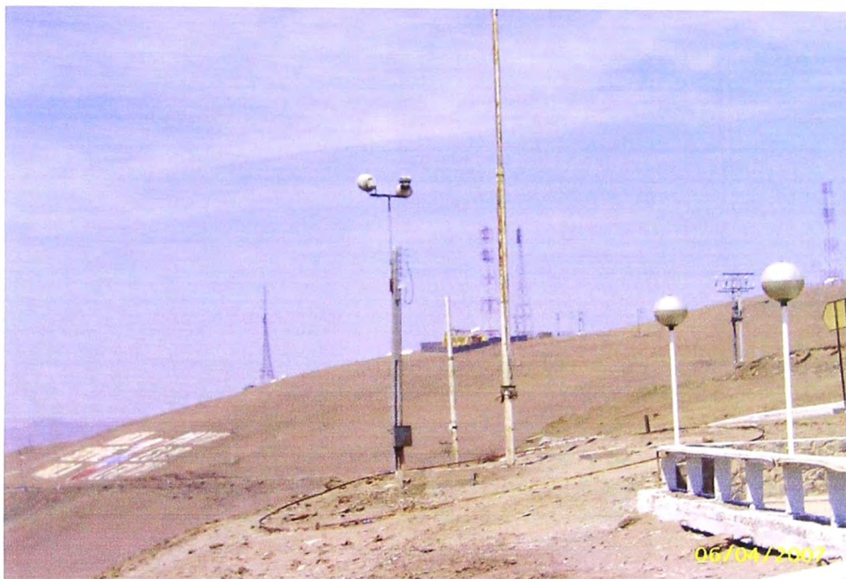
Figura 6.45.- Vista superior del Morro de Arica, se observa la instalación de antenas de varios servicios de telecomunicaciones.
