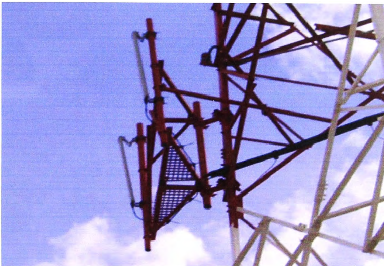
Figura 6.30.- Antenas tipo panel con un ancho de haz de 60^\circ aproximadamente y con un apuntamiento hacia el puesto de aduana y vigilancia Santa Rosa
