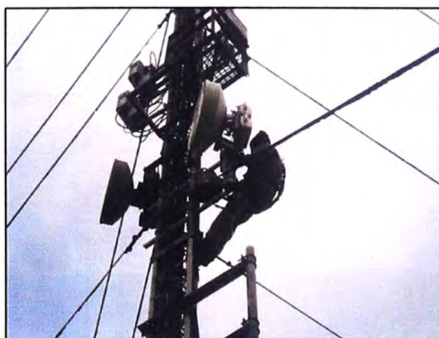
Figura 3.33 Instalación de la antena y ODU.
