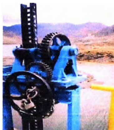
Figura N° 4.7. Mecanismo de accionamiento en Piticuli. Volante con reductor y cremallera.
