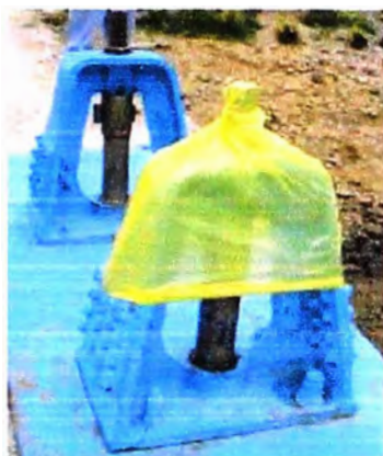
Figura N° 4.6. Mecanismo de accionamiento en Huasca. Eje central accionado por palanca
