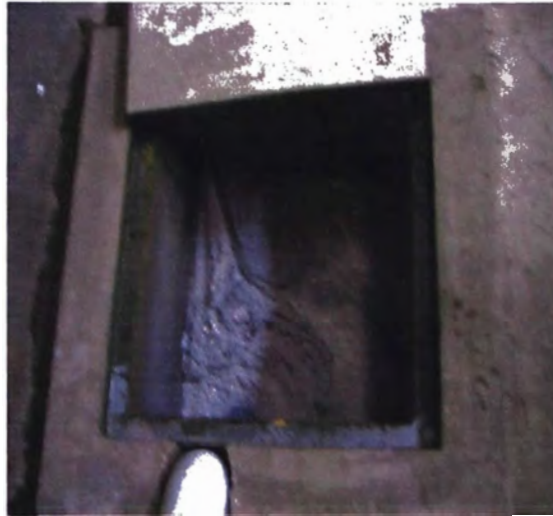
Registro de ingreso a la poza de retención de sedimentos y flotantes.
