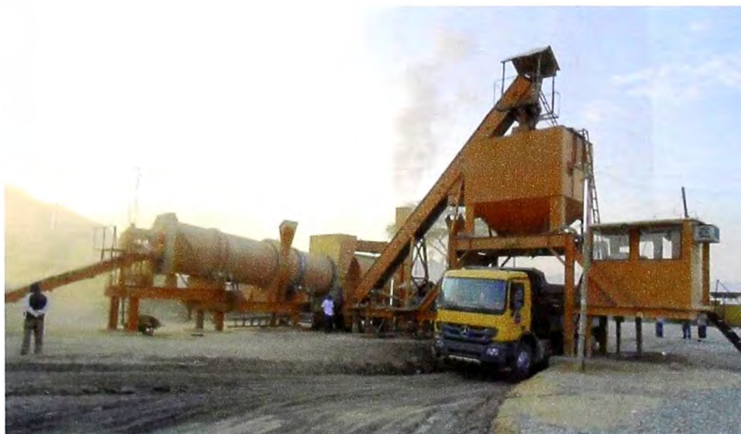
Producción de Asfalto
