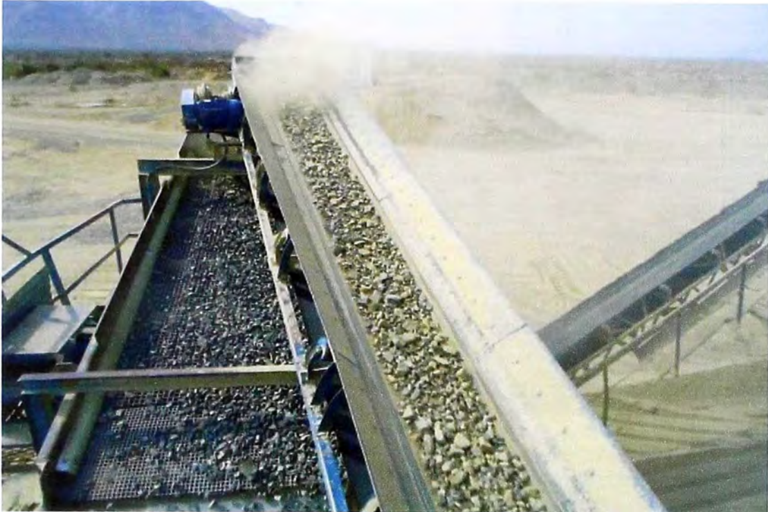
Transporte de material y Zaranda
