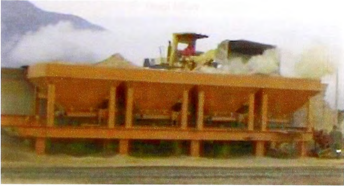
Silos de Abastecimiento
