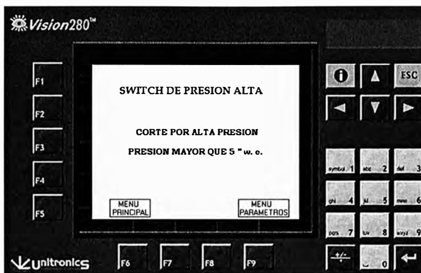
Fig. 4.5 Estado del Switch en el Punto de Falla
