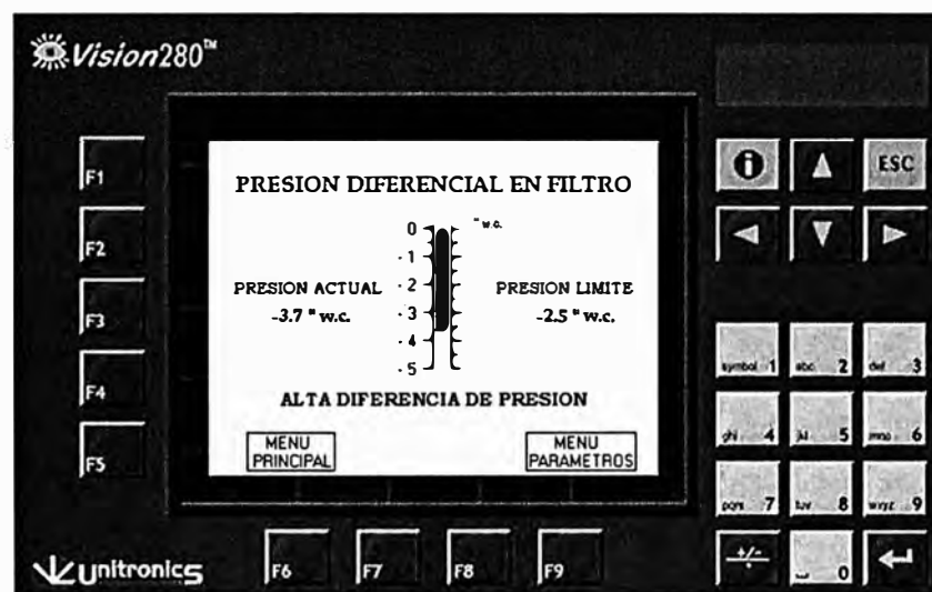
Fig. 4.4 Presión en el Punto de Falla
