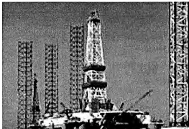
Fig. 1.5 Torre de perforación de petróleo.
