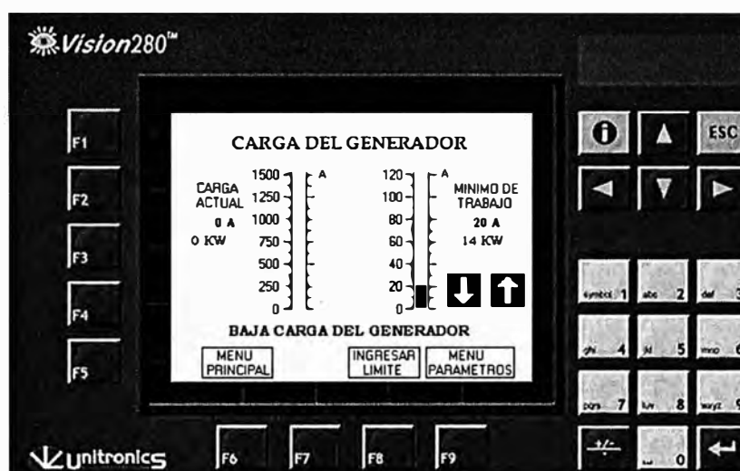
Fig. 4.7 Carga del Generador
