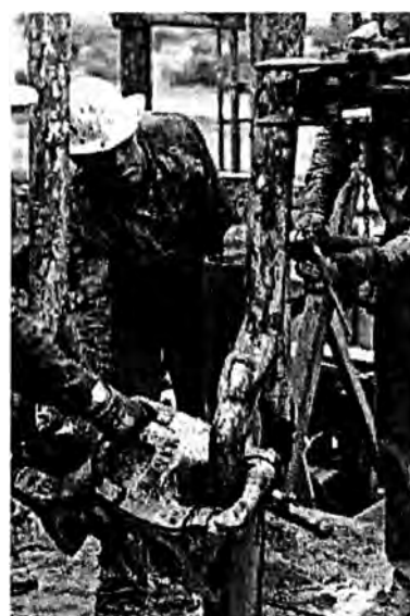
Fig.1.3 Perforación de Pozo
