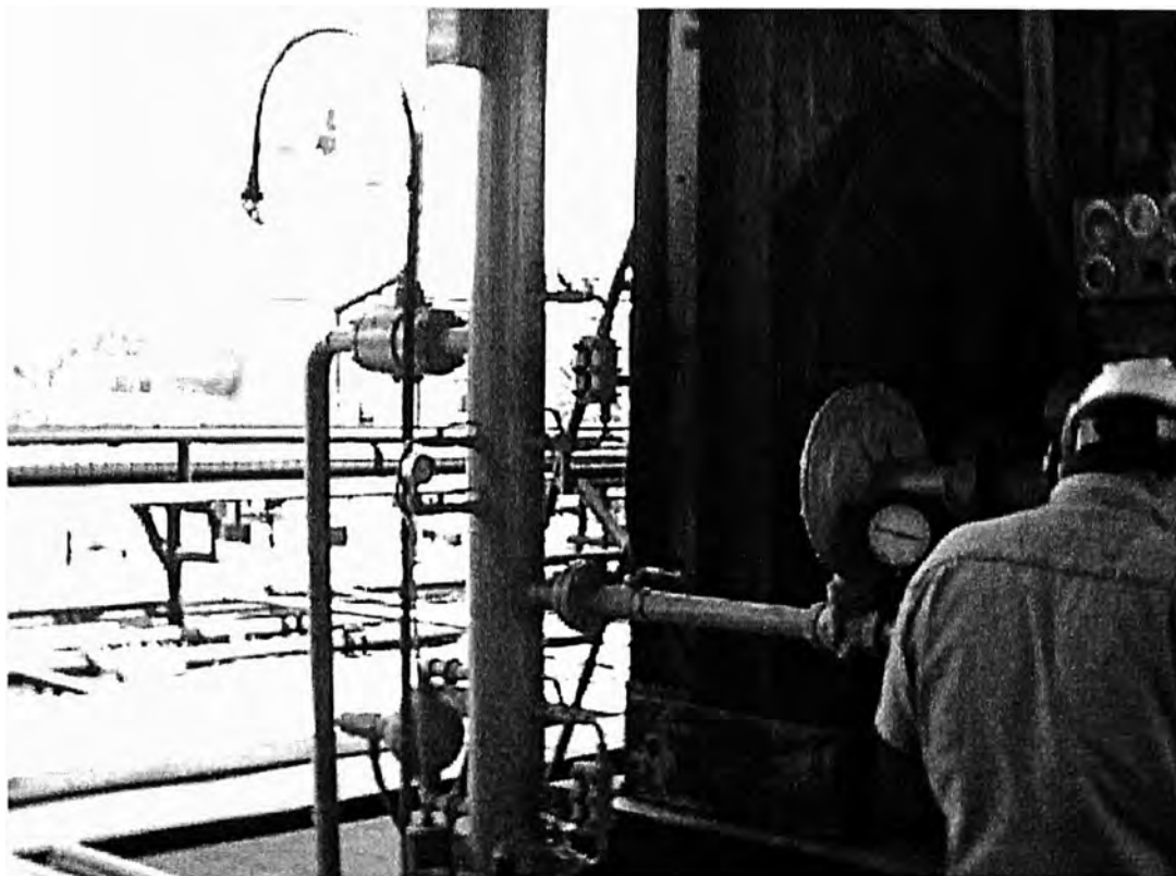
Fig. 2.3 Alimentador de Gas Natural y Filtro Primario
