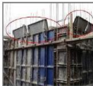
Colocación de chutes
