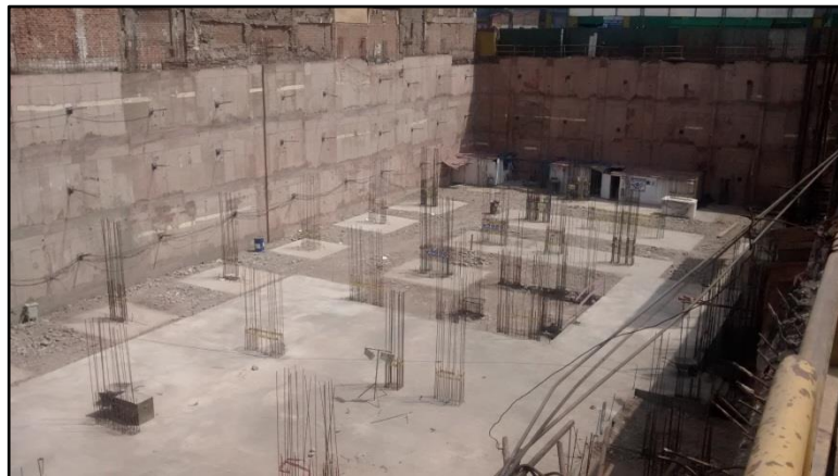
Figura N° 15: Vista de los elementos verticales del sótano 2 (Fuente: Fotos tomadas en la obra CCH)
