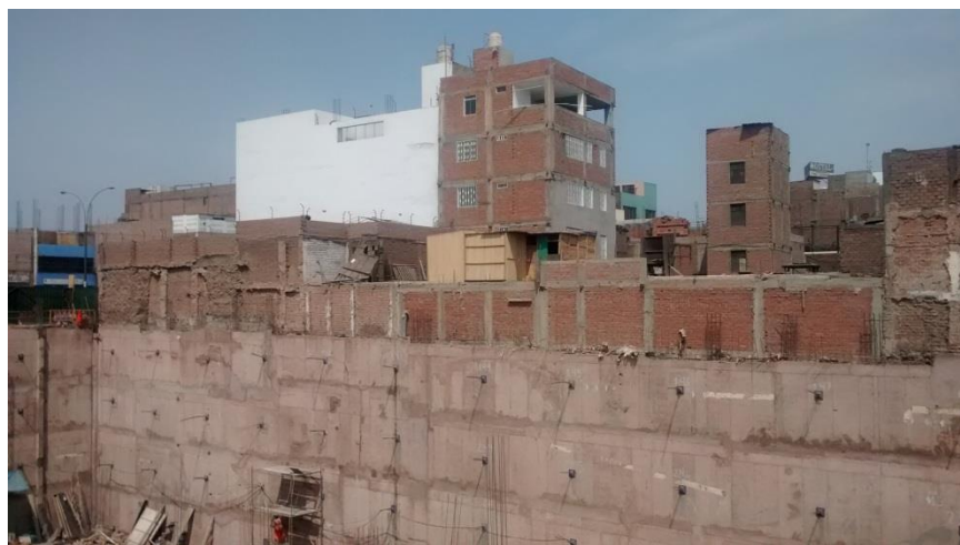
Figura N° 14: Vista de los muros pantallas colindantes con terceros (Fuente: Fotos tomadas en la obra CCH)
