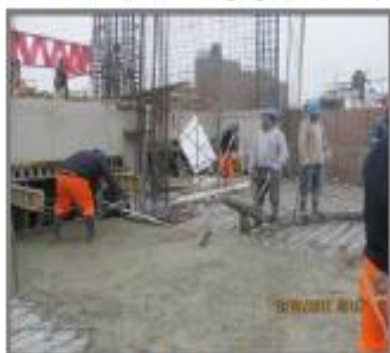
Vaciado en losa de techo
