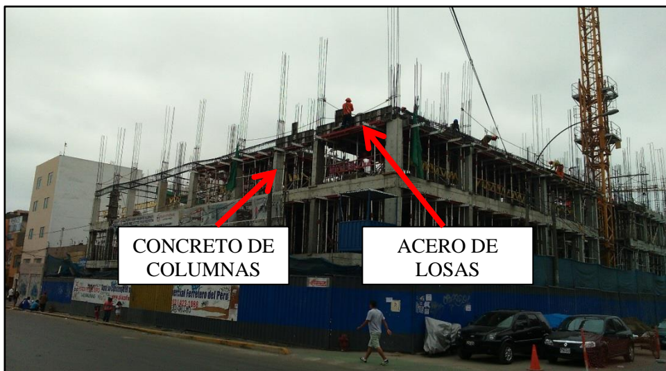
Figura N° 10: Vista en perspectiva de los trabajos: concreto de columnas y acero de losas (Fuente: Fotos tomadas en la obra CCH)
