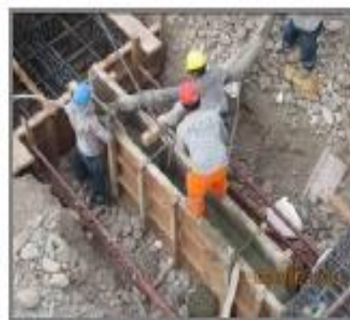
Vaciado en viga de cimentación
