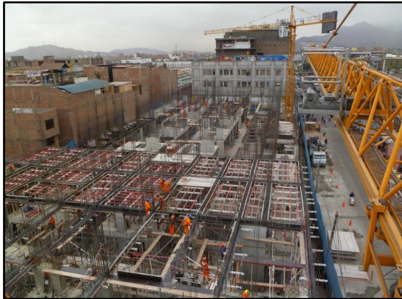
Figura N° 5: Vista en perspectiva del proyecto en ejecución (Fuente: Fotos tomadas en la obra CCH)
