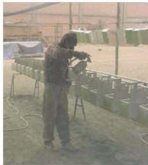
Figura 3.27. Aplicación de esmalte epóxico gris.
