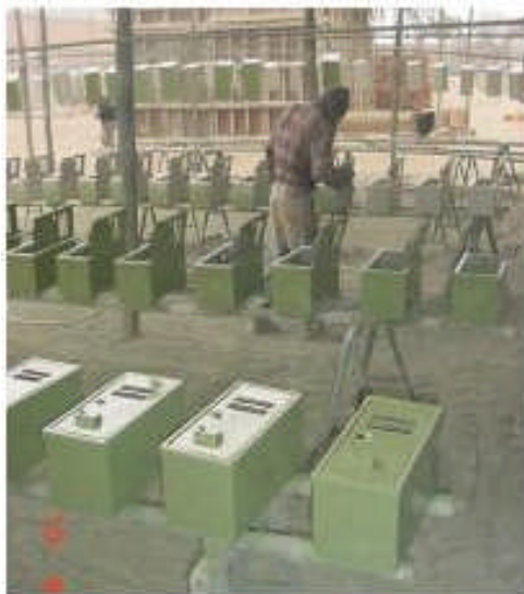
Figura 3.26. Aplicación de base zincromato epóxico
