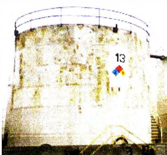
Figura 4: Corrosión Generalizada
