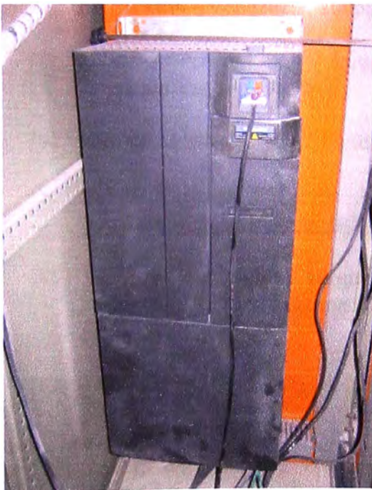
Medición en la entrada de Convertidor AC/AC (Motor AC 55kW)
