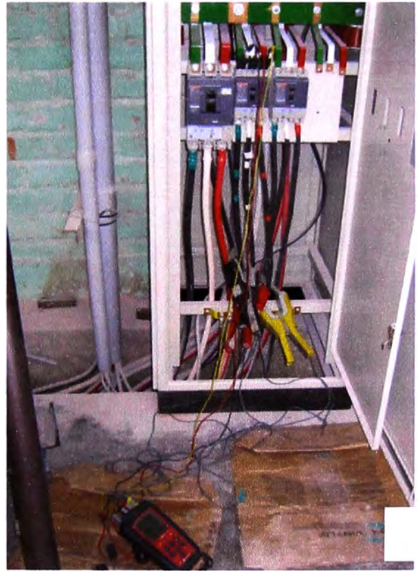
Medición en tablero general en 440Vac de la planta
