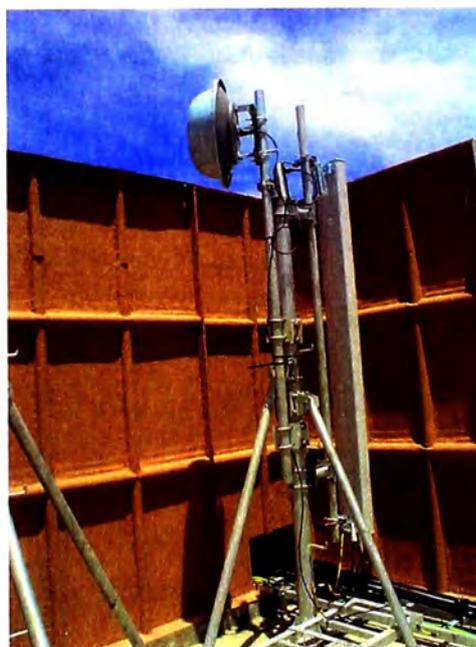
Figura 2.3. Antena de enlace para el Microlink
