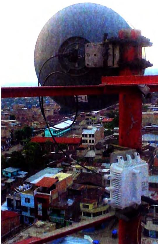
Figura 2.10 Antena y ODU del Pasolink Neo 1+0 (11 – 52 GHz)
