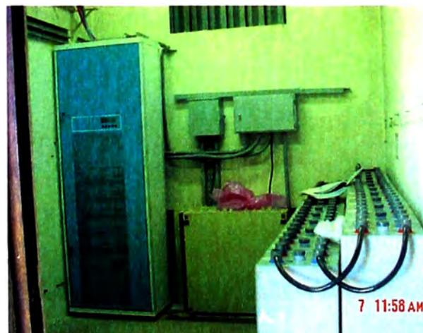
Figura 4.10 Vista de Rectificador Emerson y banco de baterías.
