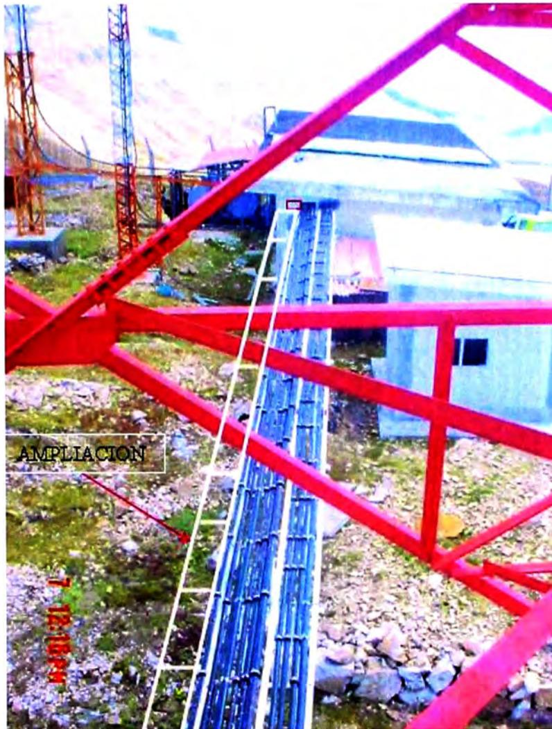
Figura 4.9 Trabajo Adicional, se requiere ampliación de escalerilla horizontal y apertura de boquete adicional para el paso de la nueva guía de onda.
