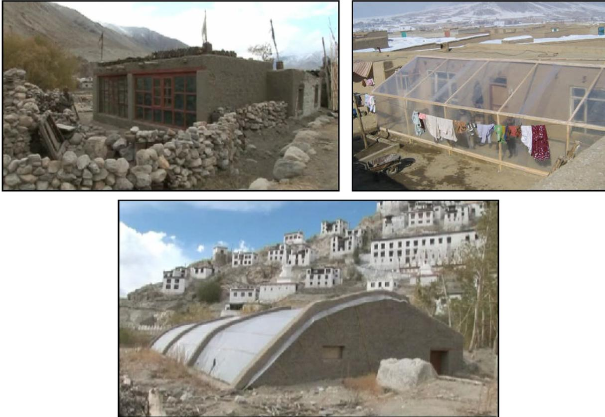
*Figura 1.7. Arriba: a la izquierda se observa una vivienda propuesta por GERES, la pared sur posee grandes ventanas y muros Trombe; a la derecha se observa un invernadero adosado a los ambientes de la vivienda. Abajo: un invernadero el cual provee de alimentos durante el invierno, (GERES, 2009).*
