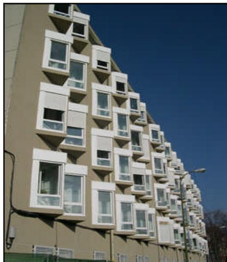
Figura 2.15. Edificio con sistema de captación de radiación solar a través de ventanas. España.
