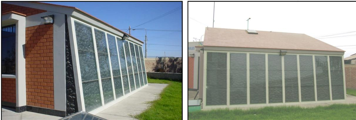
*Figura 2.26. Muro de inercia instalado en el CERT de la Universidad Jorge Basadre de Tacna.*
