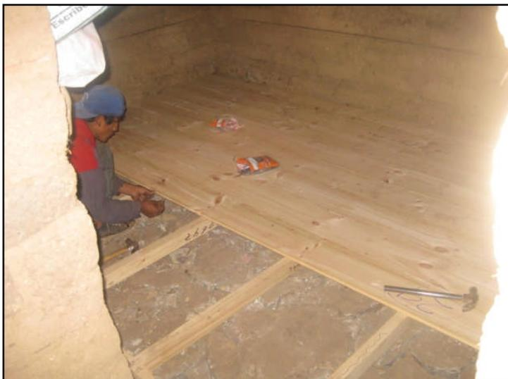
*Figura 4.34. Arriba: proceso de sellado de los intersticios usando barro. Medio: colocación de la cama de piedras y durmientes de madera. Abajo: instalación del entablado de madera.*
