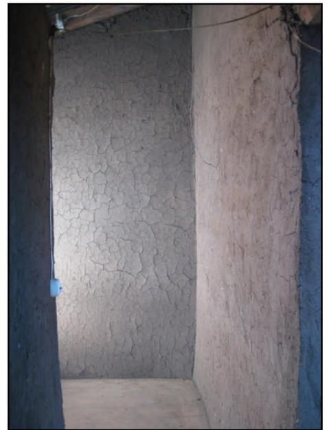
*Figura 4.33. Arriba: en las claraboyas, hojas interiores de triplay cerradas. Medio: hojas de madera en ventanas. Abajo: muros de la fachada principal e interiores tarrajeados con barro.*
