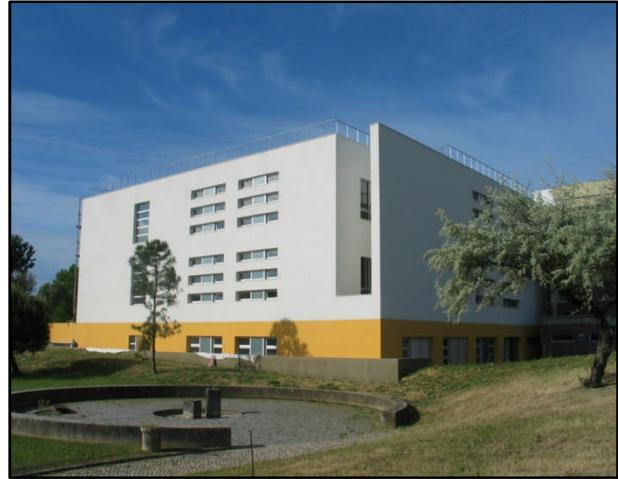
*Figura 1.9. Edificio solar demostrativo construido por el INETI. A la izquierda, se observa la pared sur en la cual hay grandes ventanas y paneles fotovoltaicos. A la derecha, la pared norte en la cual las ventanas son mucho más pequeñas, (Gonçalves, 2 005).*
