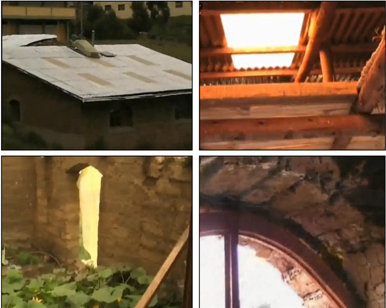
*Figura 1.5. Arriba: a la izquierda la casa solar, a la derecha detalle de la claraboya en el techo y en el cielo raso. Abajo: a la izquierda el invernadero adosado a la vivienda, a la derecha detalle del doble muro aislante térmico.*
