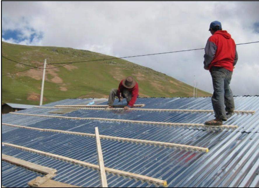
*Figura 4.30. Aislamiento térmico del techo. Colocación de correas de pino seco.*
