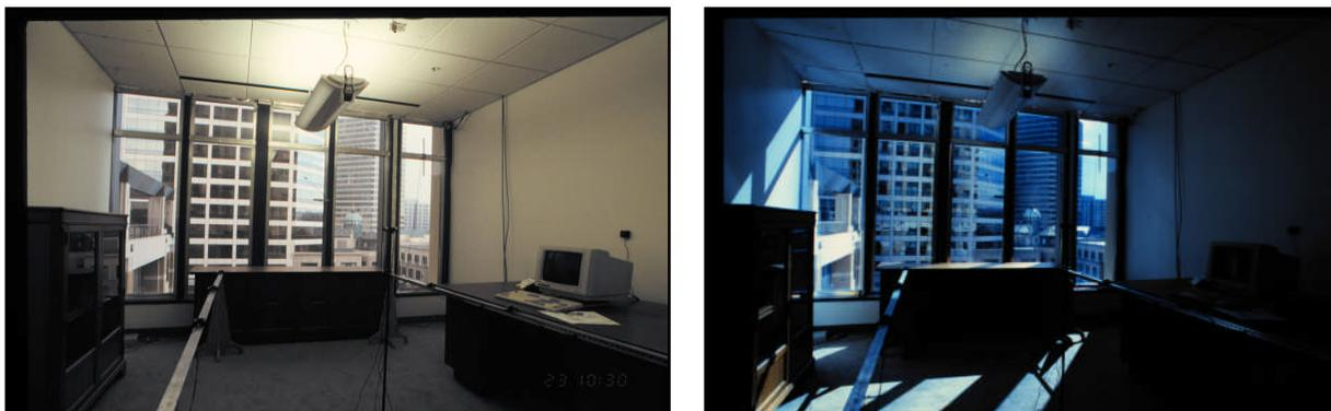
*Figura 2.16. Ventanas inteligentes. A la izquierda estado claro. A la derecha estado oscuro.*
