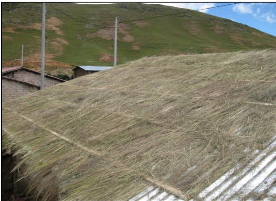
*Figura 4.31. Aislamiento térmico del techo. Colocación del colchón de ichu.*
