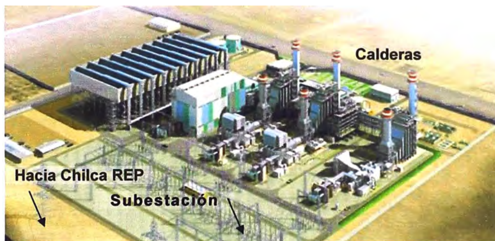
Figura 3.4 Vista perspectiva de la CT Chilca Uno (Fuente: Ref. [7])
