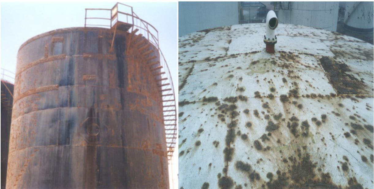
Figura 4.1. Corrosión en tanques
