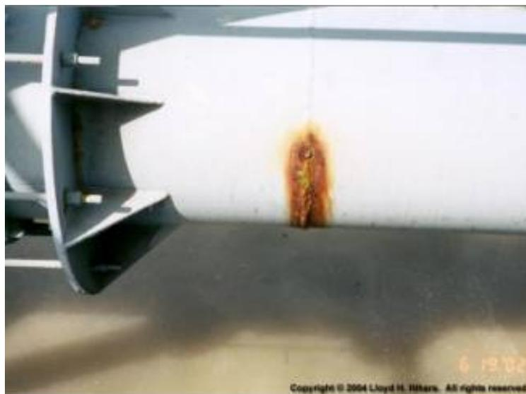
Figura 4.6. Corrosión por picadura
