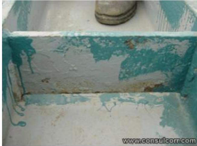
Figura A4.3. Aplicación deficiente
