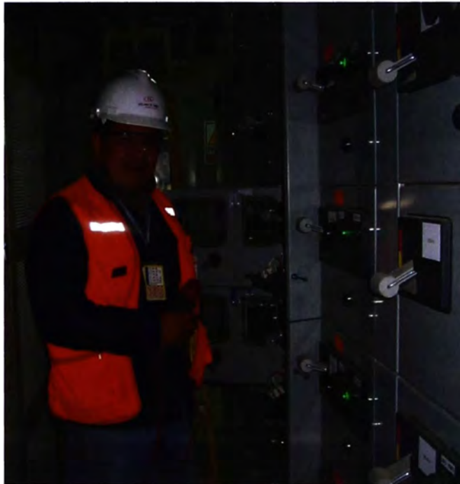
Fig. 2.6 Centro de Control de Motores en 480V
