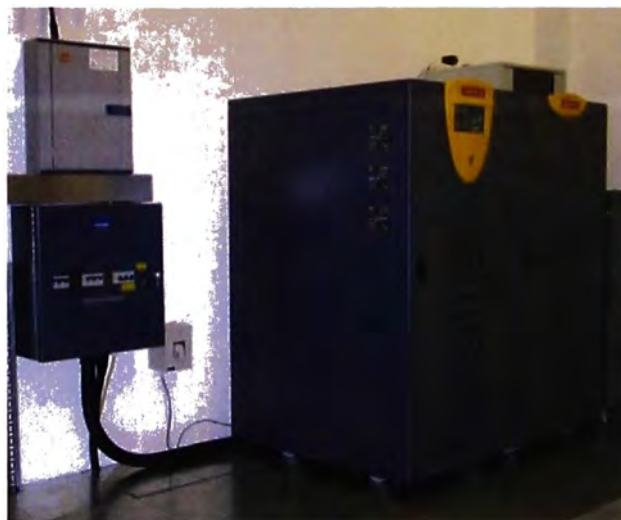
Fig. 2.8 Sistema Ininterrumpido de Poder
