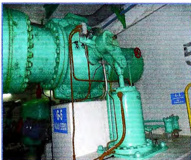
Fig. 4.6. Regulador de velocidad
