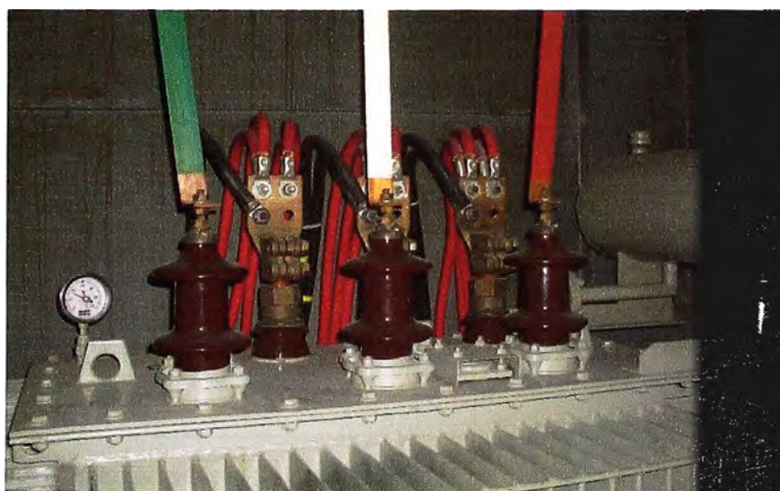
Fig. 3.5 Inicio del mantenimiento, uso de implementos de seguridad
