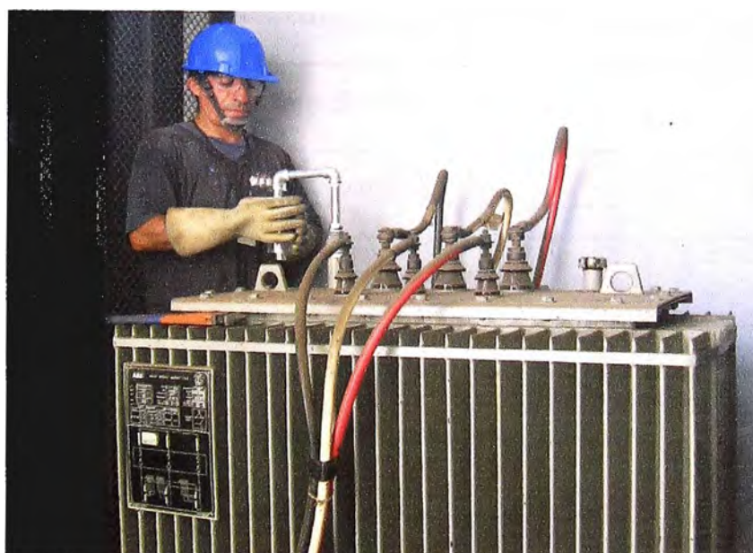
Fig. 3.6 Cambio del desecador
