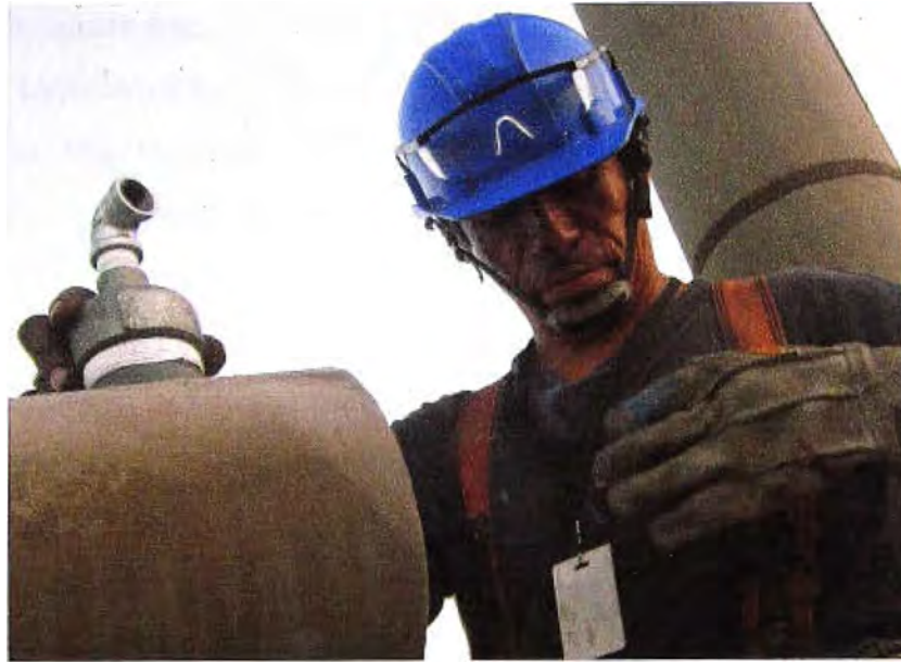
Fig. 3.4 Cambio del desecador (Instalaciones CELSA)
