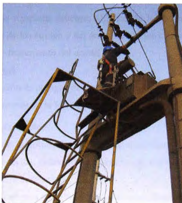
Fig. 3.3 Limpieza del transformador (Instalaciones CELSA)
