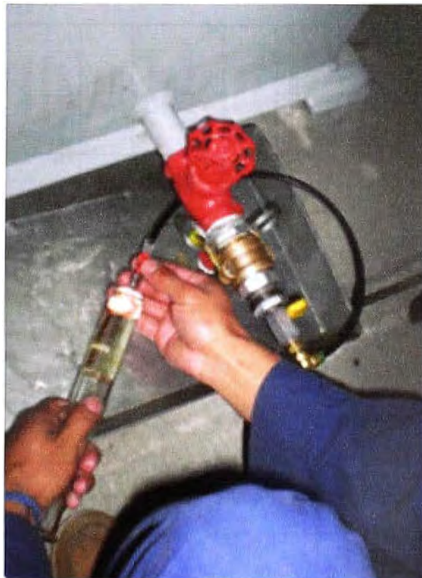
Fig. 3.11 Extracción óptima del aceite del transformador, con ampolla
