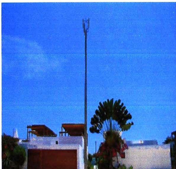
Vista del Poste que alberga los equipos
