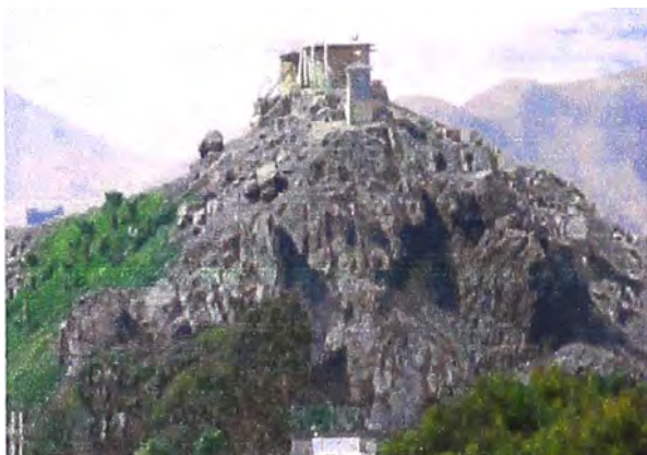
Vista de la Torre de Comunicaciones
