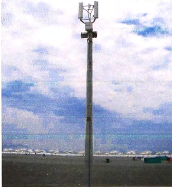
Vista de Poste que alberga los equipos
