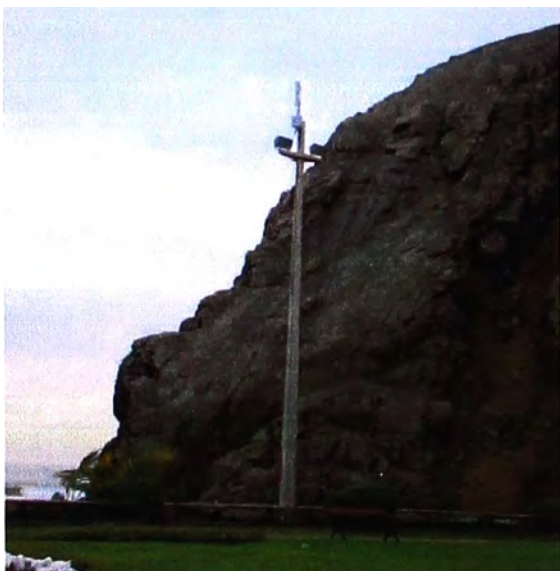
Vista del Poste que alberga los equipos
