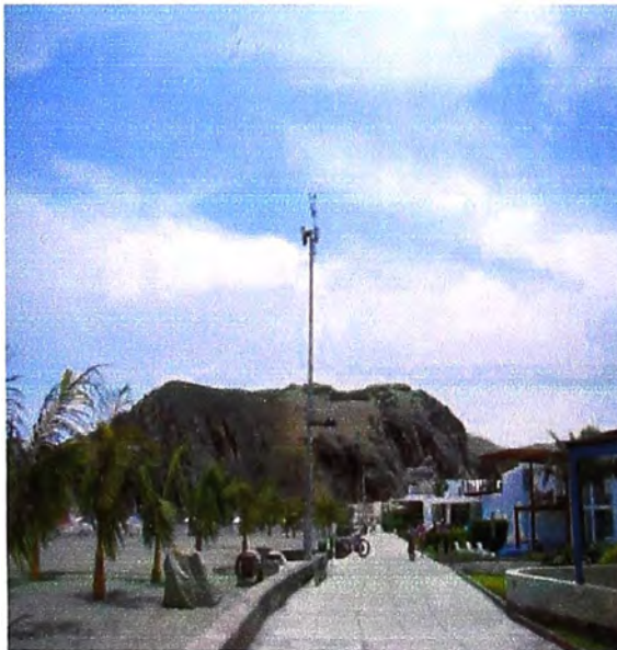
Vista del Poste que alberga los equipos
