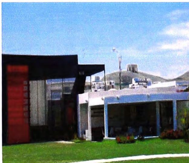
Vista del Poste que alberga los equipos
