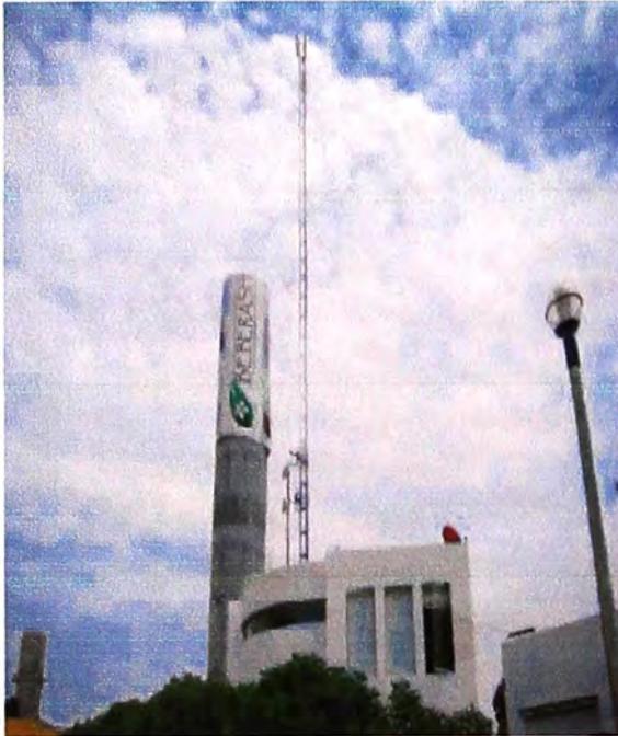
Vista del Torre que alberga los equipos
