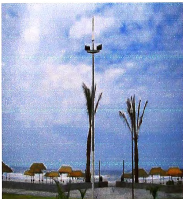
Vista del Poste que alberga los equipos
