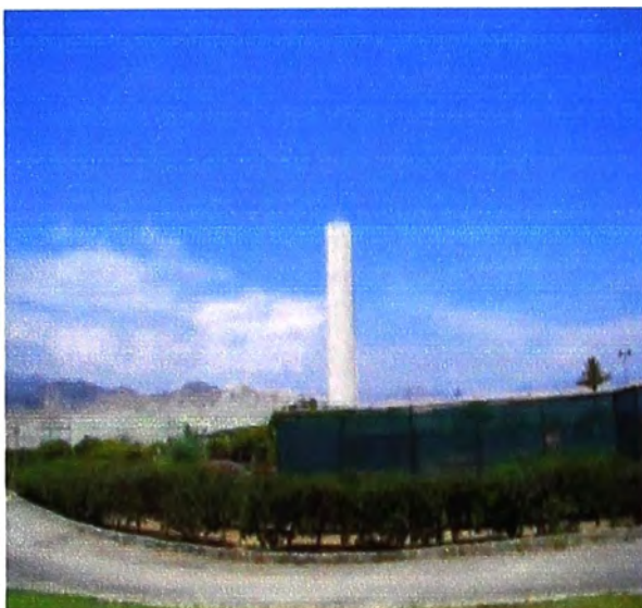
Vista de Pozo de Agua que alberga los equipos
