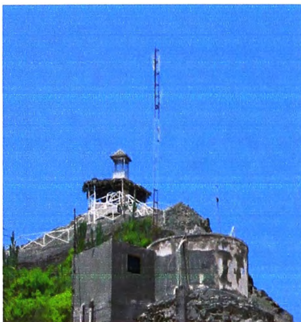
Vista de la Torre de Comunicaciones
