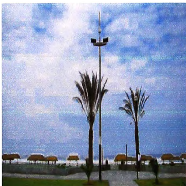
Vista del Poste que alberga los equipos
