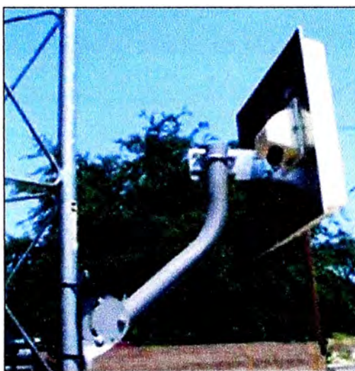
Figura 3.12. Montaje de la Antena
