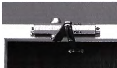
Fig.2.11 Cierra puerta hidráulico[88]
