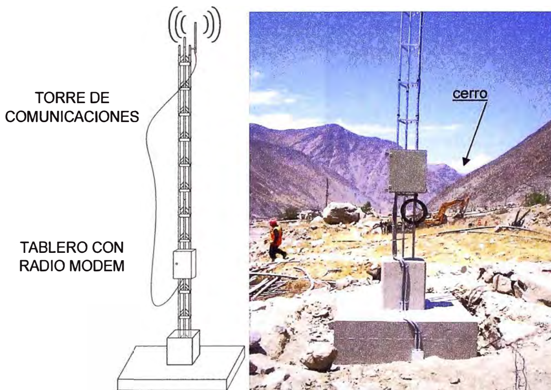
Figura 3c. Esquema y fotografía de estación repetidora
