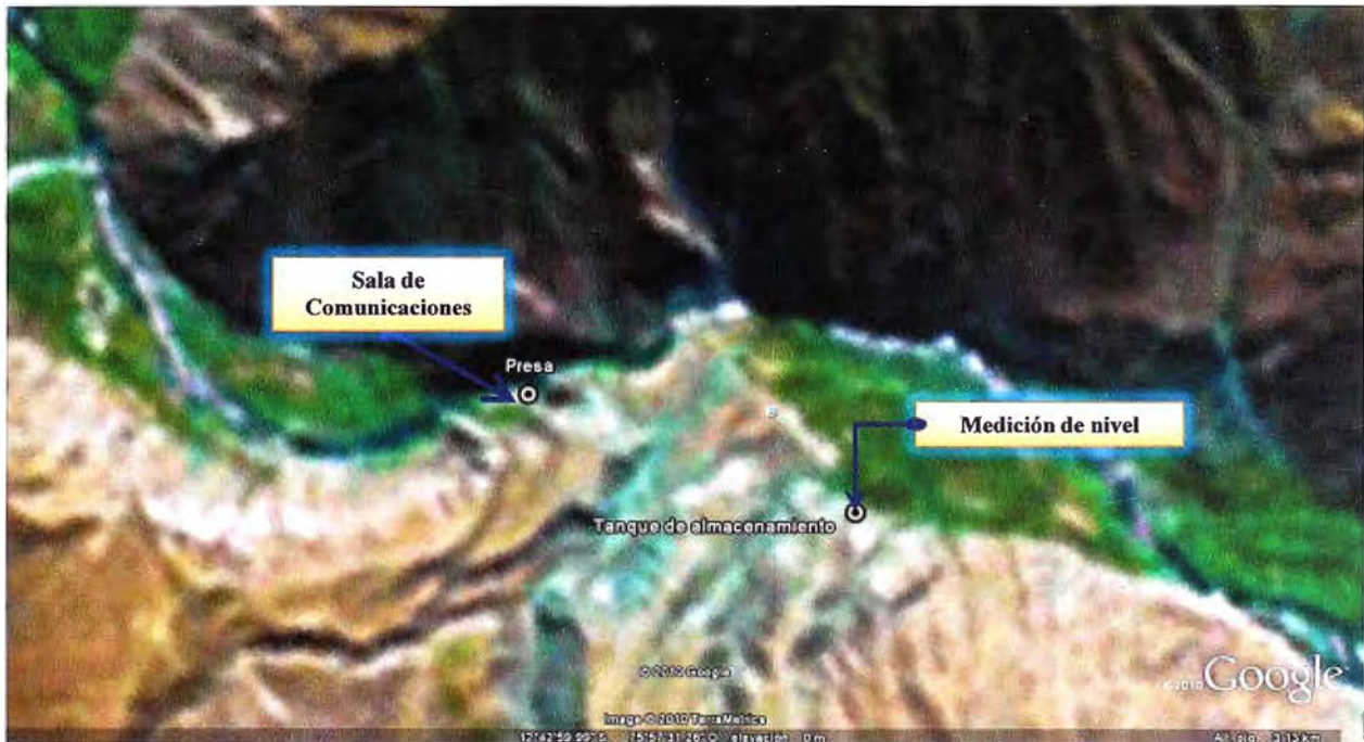
Figura N° 1.1 Vista general de la presa
