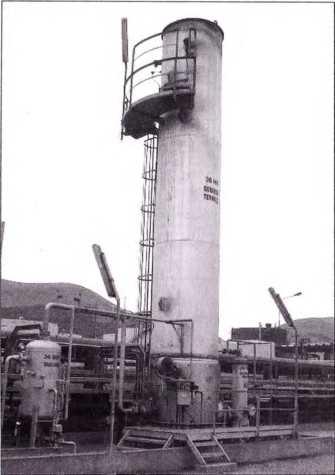
Figura 3.2. Estructura del quemador enclosed
