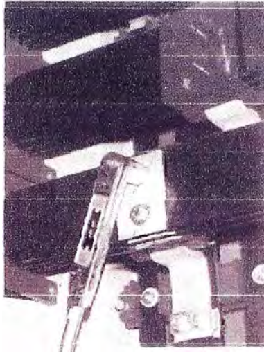
Fig. 3.5: Montaje de barras derivadas.
