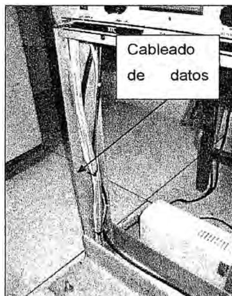
Figura 6.16 Ingreso del cableado de datos al rack de comunicaciones
