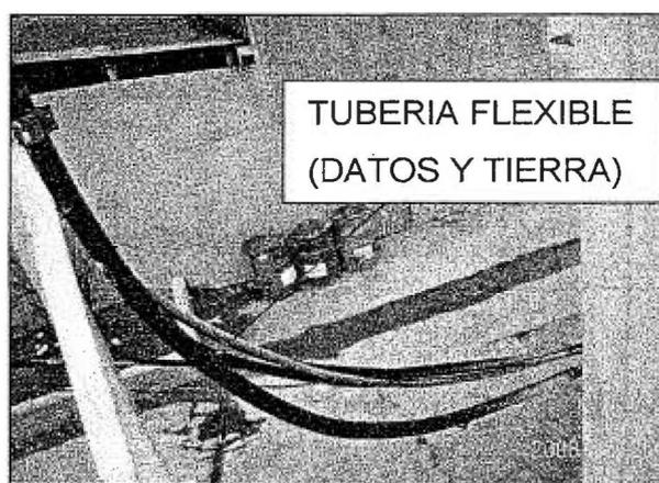
Figura 6.4 Bajada del Cable de datos y tierra (se encuentra dentro de tubo flexible color negro)
