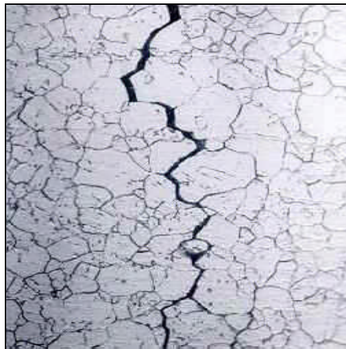
Figura 5 Corrosión bajo tensión.
