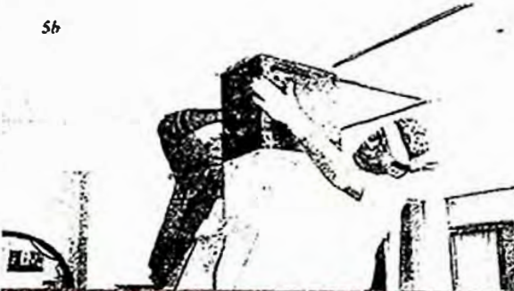
5a y 5b. Uso de mantas en encuentro columna-viga.
