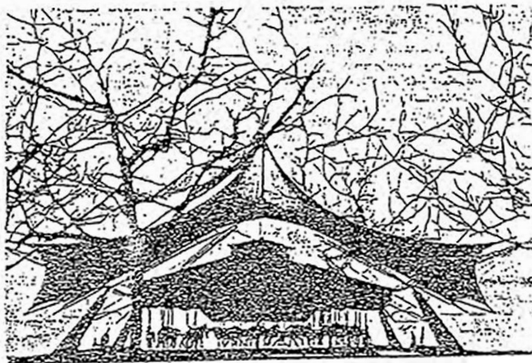
Estructura tensionada sobre cuatro columnas oblicuas empotradas, en donde ningún tensor llega al suelo, fijando completamente los cables
