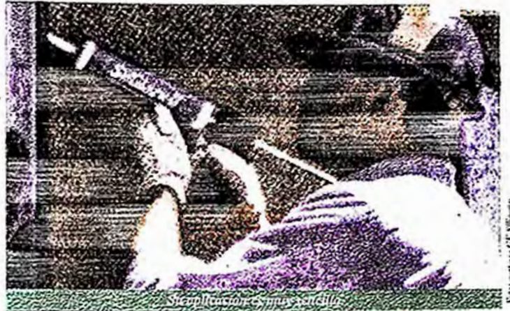
Simplificación de juntas con silicona
