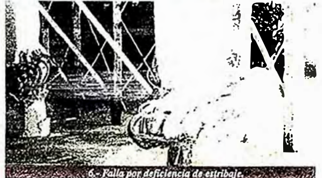
6. Falla por deficiencia de estribaje.
