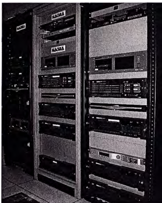
Fig. 3.11 Sistema de Acceso Condicional (CAS) Nagravision
