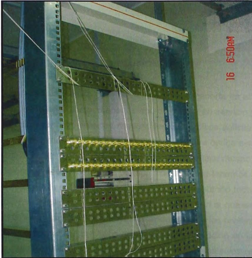
Fig 3.18 Bastidor con regletas para E1s y STM-1
