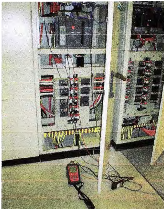
ANEXO E: TOMA DE DATOS TABLERO GENERAL DE EMERGENCIA TG-E1
