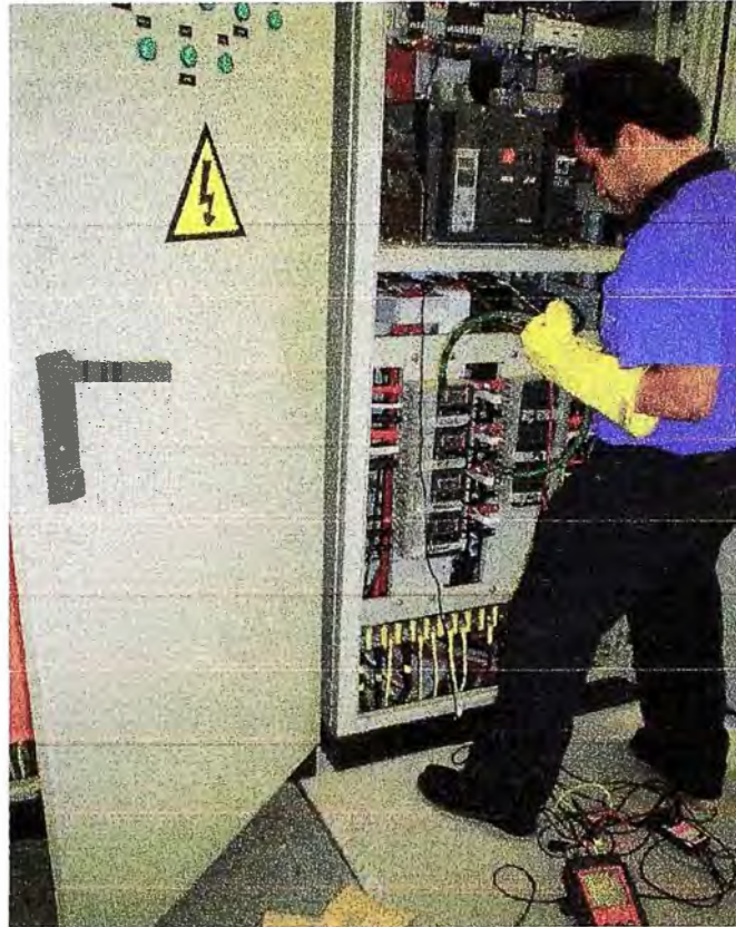
ANEXO C: LOS TRABAJOS SE REALIZAN CON LA ADECUADA PROTECCIÓN
