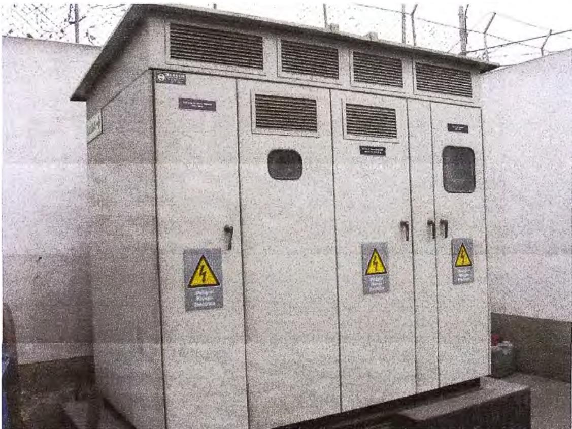
Figura 2.1 Subestación compacta pedestal
