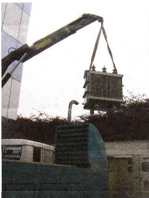
Figura 4.9 Retiro del transformador para mantenimiento
