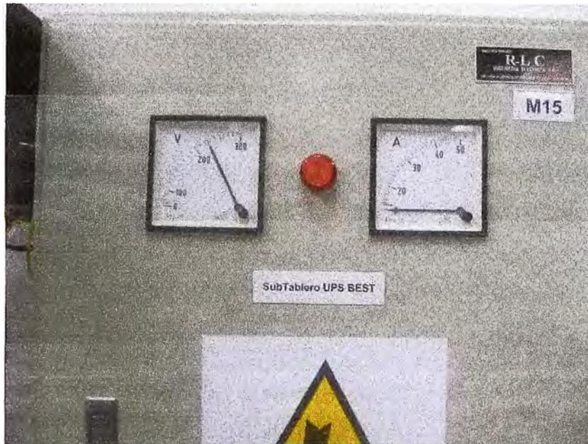
Figura 2.14 Tablero con medidor con medición directa
