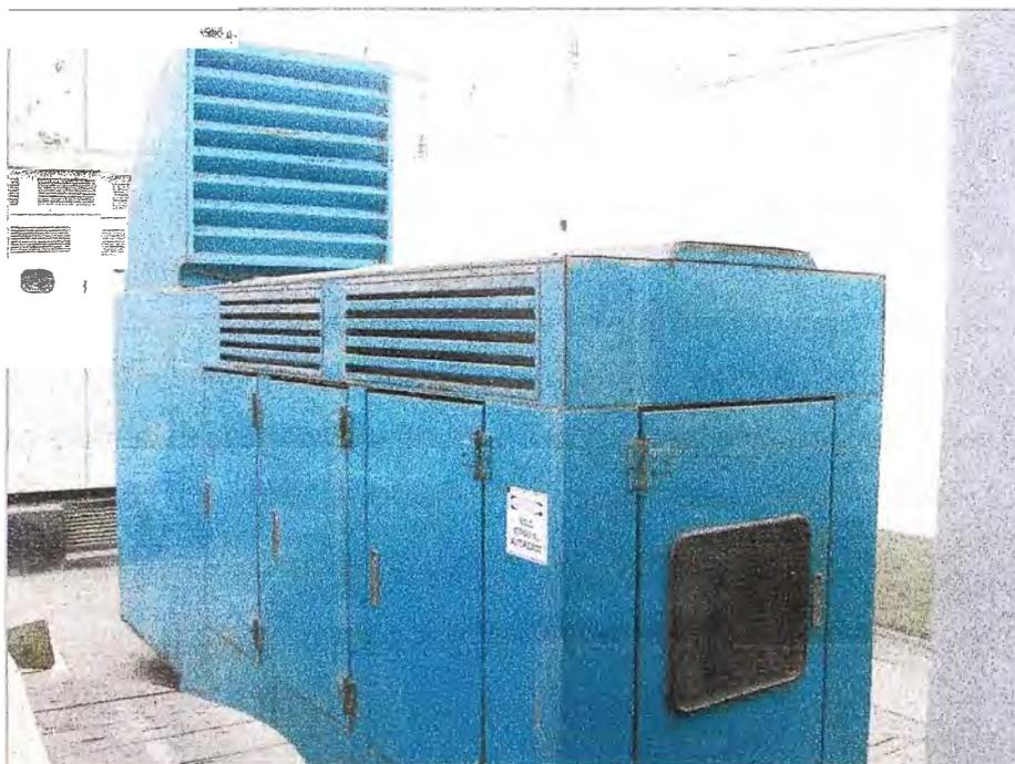
**Figura 2.8** Grupo Electrónico encapsulado Cummins Onan
