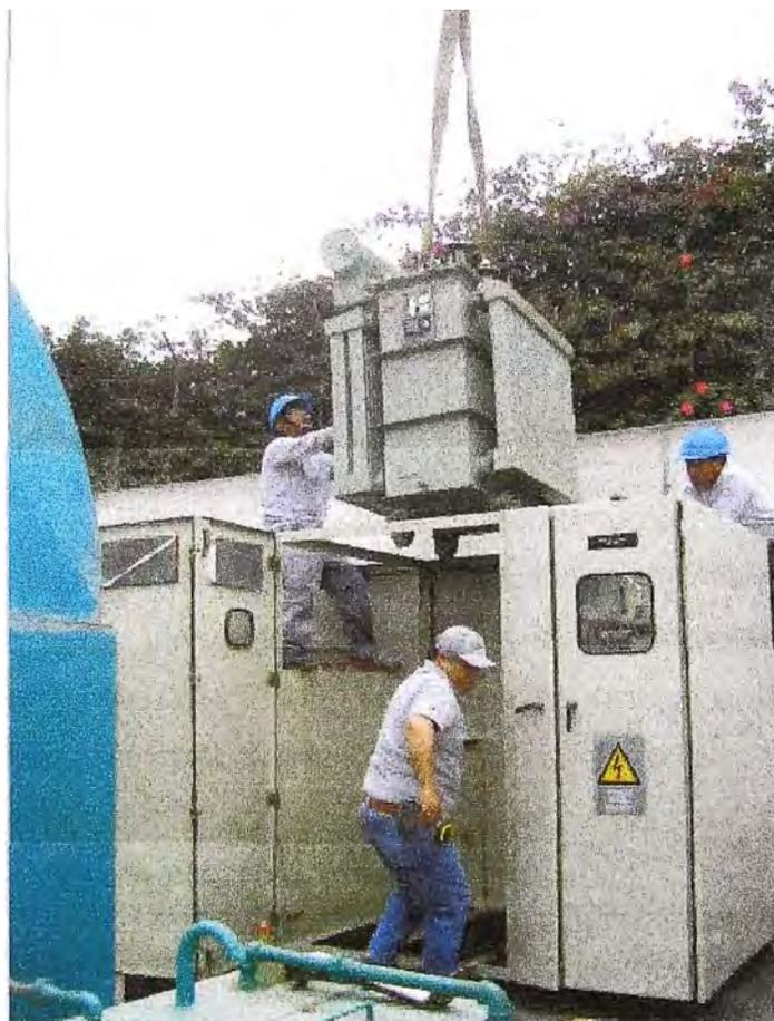
Figura 4.8 Retiro del transformador para mantenimiento
