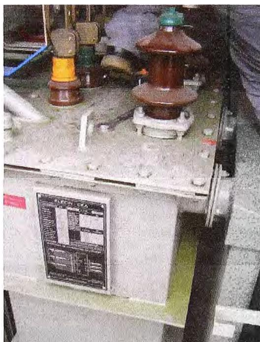
Figura 4.7 Fuga de aceite (plataforma bajo la placa)
