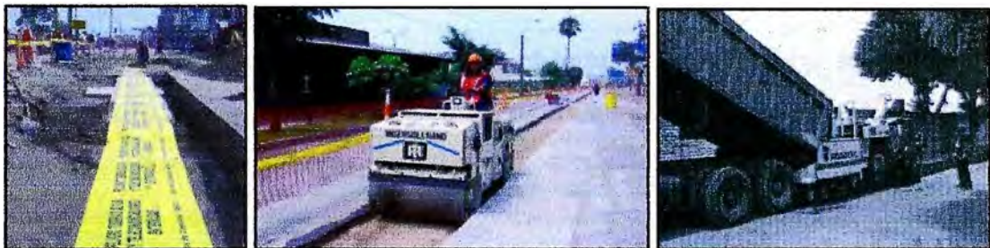
Fig. 2.17 Colocación de cinta de seguridad, compactación final y asfaltado
