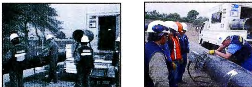
Fig. 2.19 Instalación de equipo y prueba de ultrasonido
