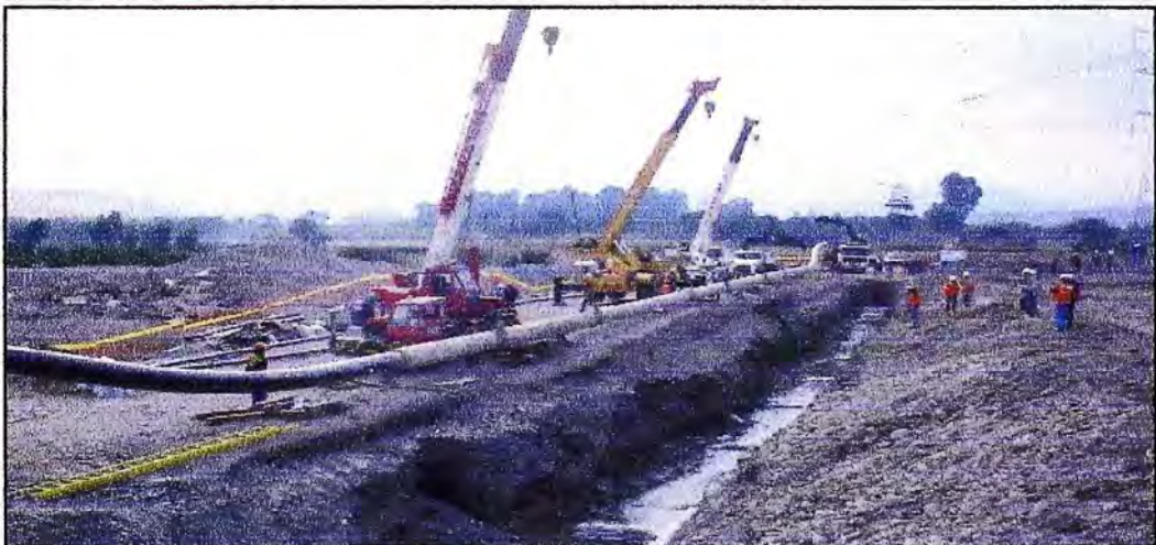
Fig. 2.27 Bajado de la tubería en el cruce del Rio Lurín
