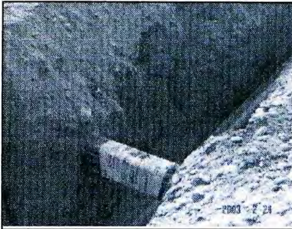
Fig. 2.23 Cables de energía
