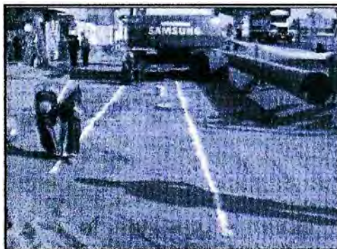
Fig. 2.9 Marcado del trazo
