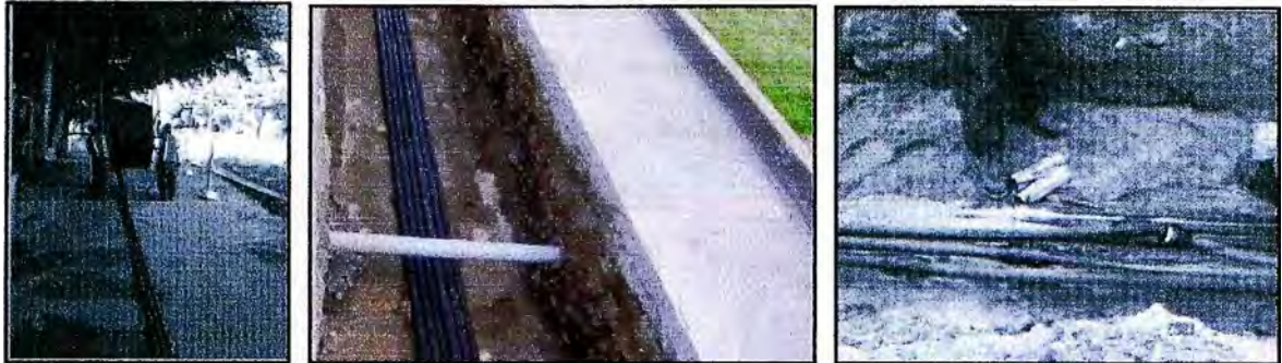
Fig. 2.16 Desplazamiento, tendido y empalme de triducto
