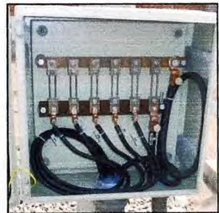
Caja de unión (Junction Box)
