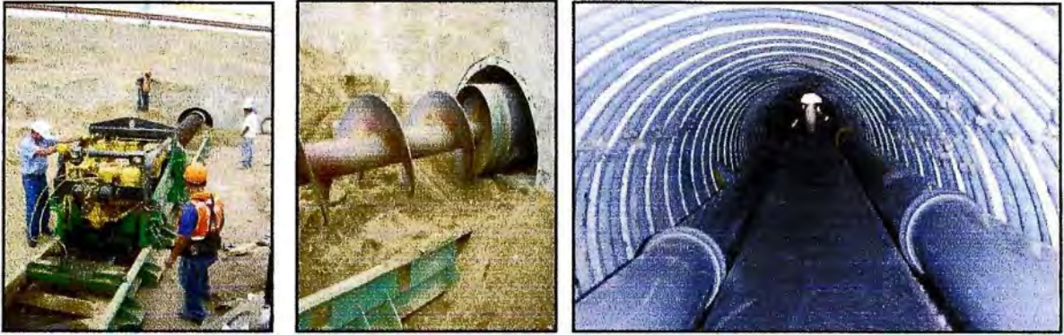
Fig. 2.26 Construcción de Tunelling
