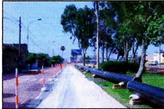
Fig. 2.10 Desfile de tuberías
