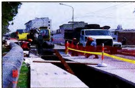
Fig. 2.11 Excavación de zanja
