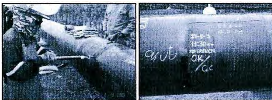
Fig. 2.20 Prueba de adherencia y parche con leyenda
