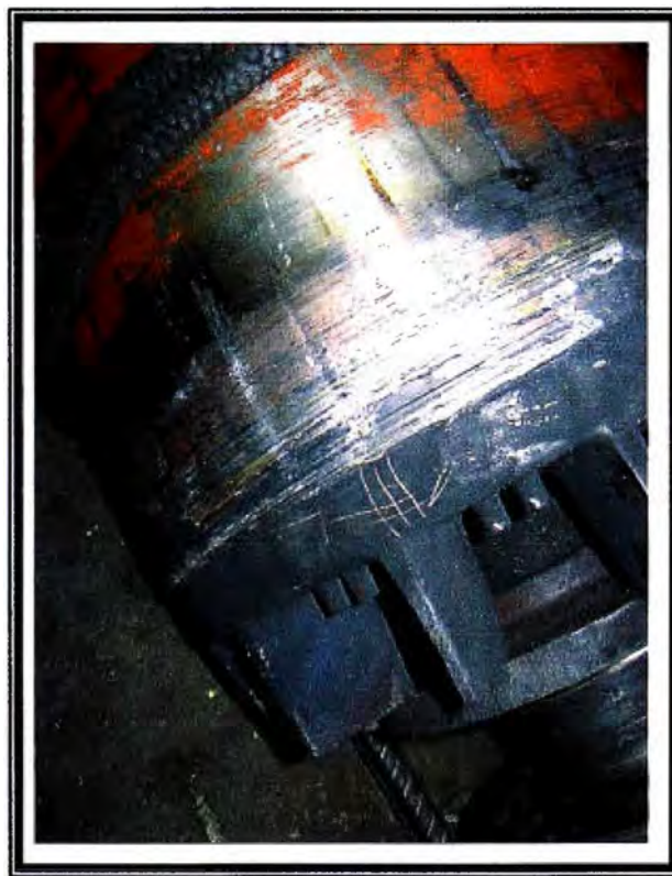
Figura 5.5 Rozamiento de Rotor con Estator, Moderado Daño en el Rotor
