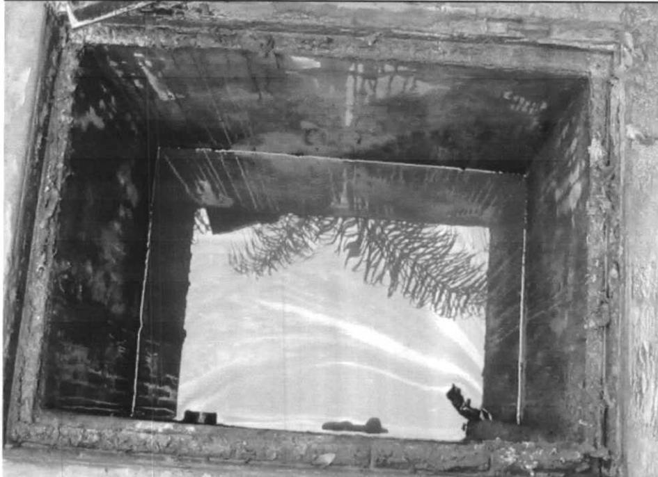
Foto N° 7: Salida de agua aceitosa de la segunda trampa a la tercera caja (muestreador), se nota capas de aceite en la superficie del agua porque la segunda trampa esta llena y no hay caja de acumulación
