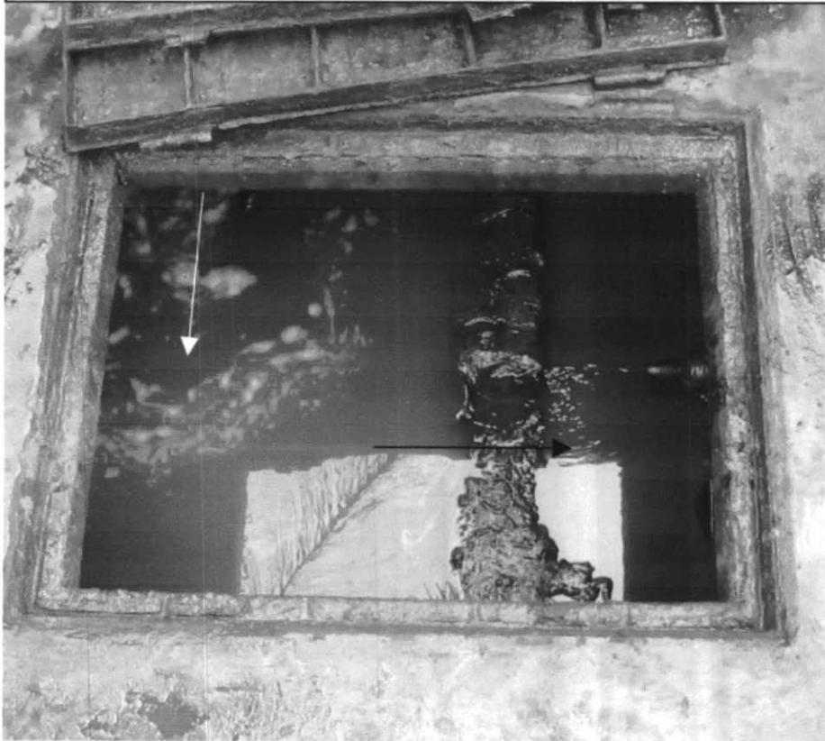
Foto N° 4: En la trampa de aceite, solo hay una salida y es por el fondo, la que se dirige al recolector de aceites que no cumple su función, en mas bien una segunda trampa de grasas.
