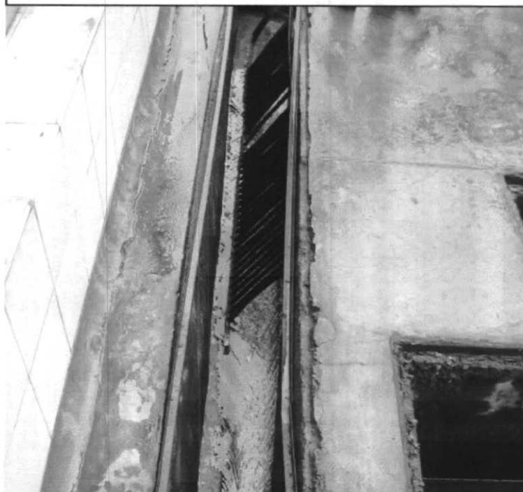
Foto N° 3: Sedimentador, muro de paso de agua superficial aceitosa no presenta una superficie uniforme. Ingreso de agua al sedimentador es lateral al muro de paso.
