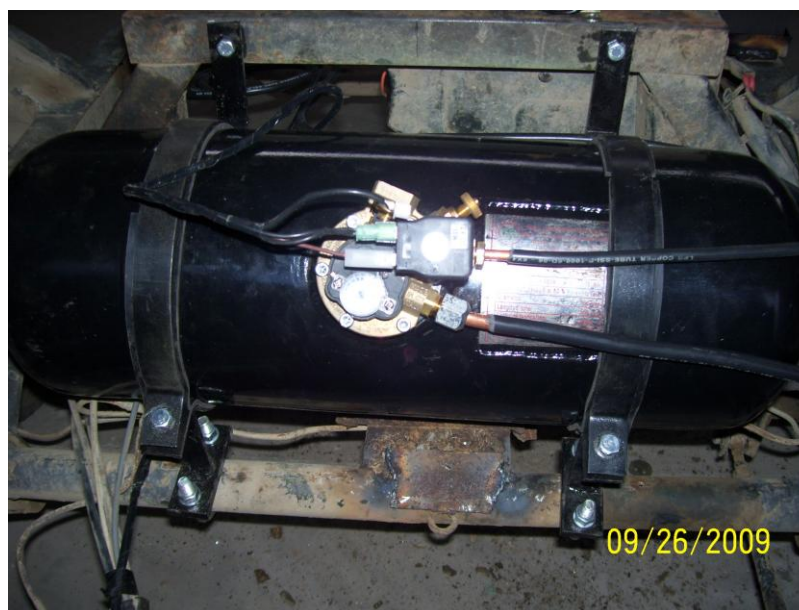
Figura N°12: Tanque para Gas Licuado de Petróleo (15 litros de capacidad)
