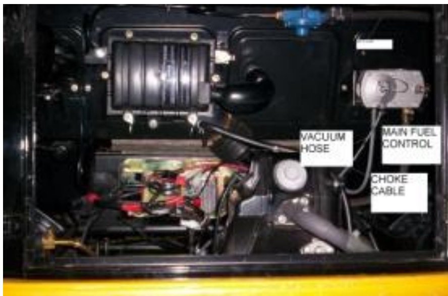
Figura N° 15: Fotografía en donde se muestran algunas partes del kit instalado
