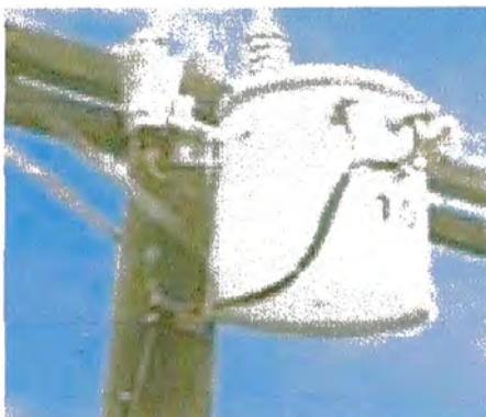
Fig. 3.3 Transformador de distribución monofásico
