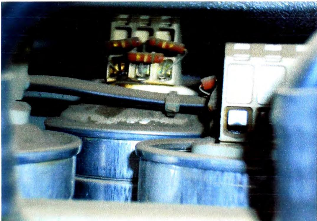
Fig. A4 Fotografía del condensador deteriorado SE-2
