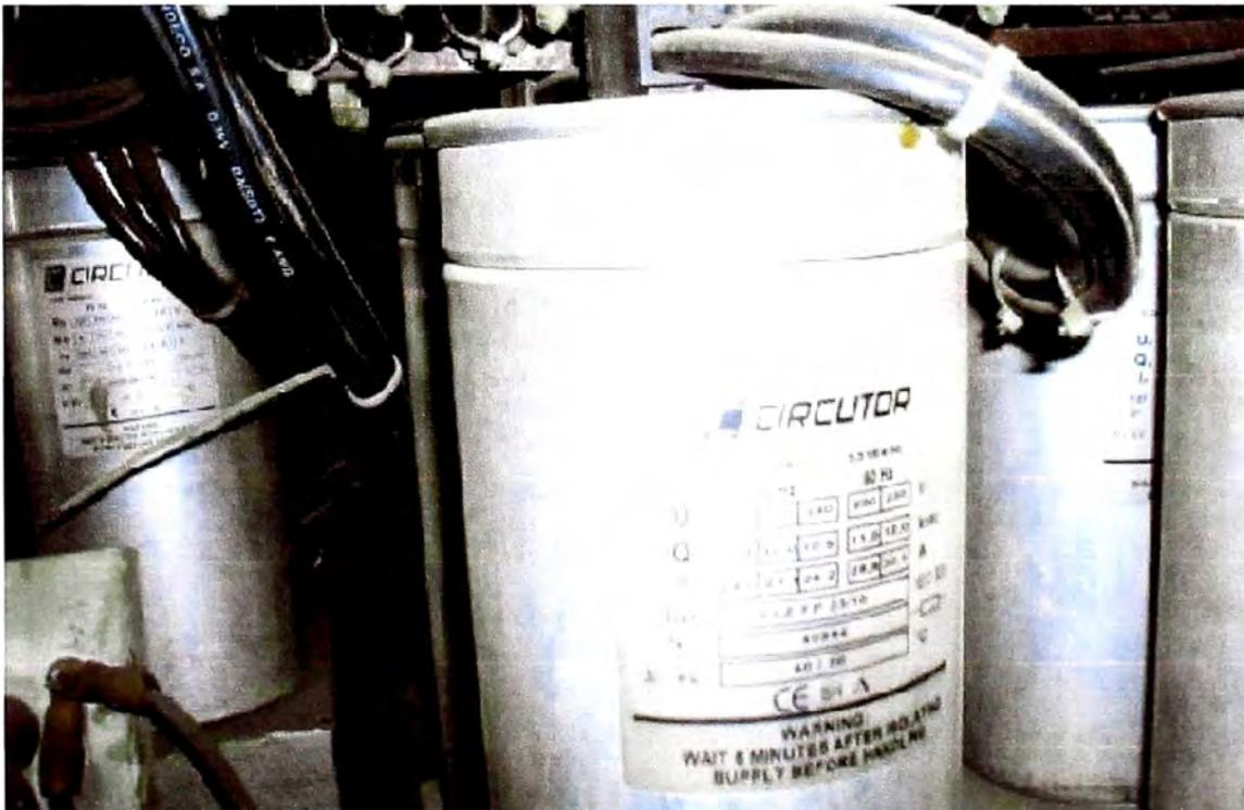
Fig. A2. Fotografía de los Condensadores CIRCUTOR instalados actualmente en el tablero del banco de condensadores automático de la SE-1
