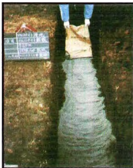
Fig. 6.5. Protegiendo el cable con cemento conductivo
