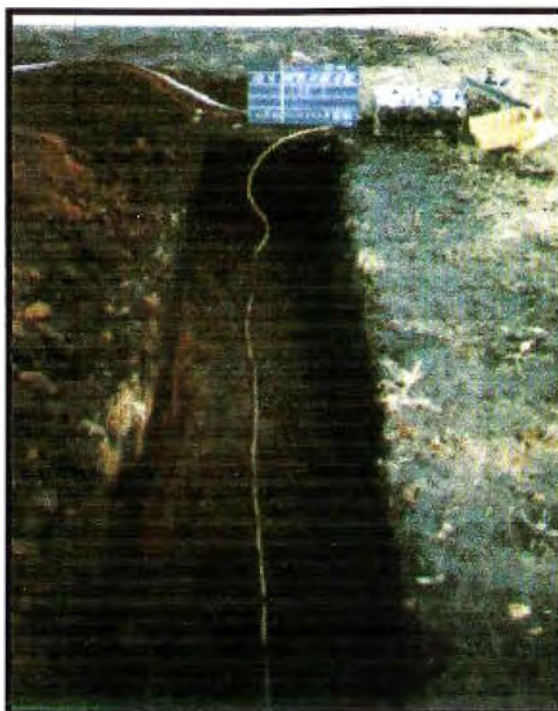
Fig. 6.4. Ubicación del cable con la zanja
