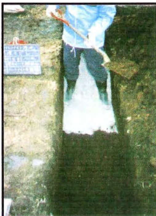
Fig. 6.8 Cubriendo el cemento conductivo con tierra cernida
