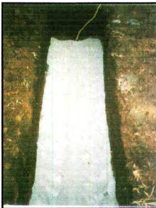
Fig. 6.7. Compactado final del cemento conductivo
