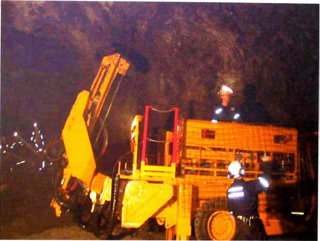
Figura 4.14. Sostenimiento mecanizado en zonas de alta sismicidad.
