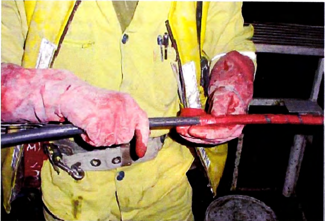
Figura 3.4. Reforzamiento de la tubería flexible
