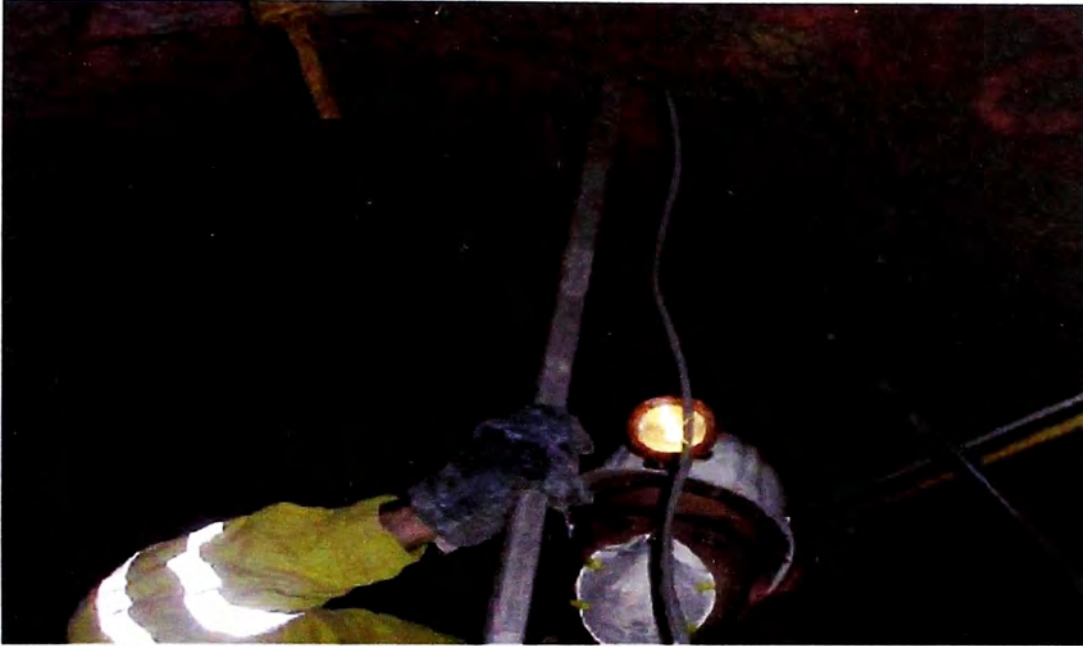
Figura 3.8. Retiro de la varilla
