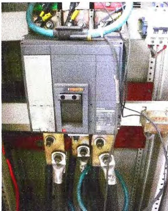
Fig. 4.2 Instalación del analizador de redes en el tablero de 460 V
