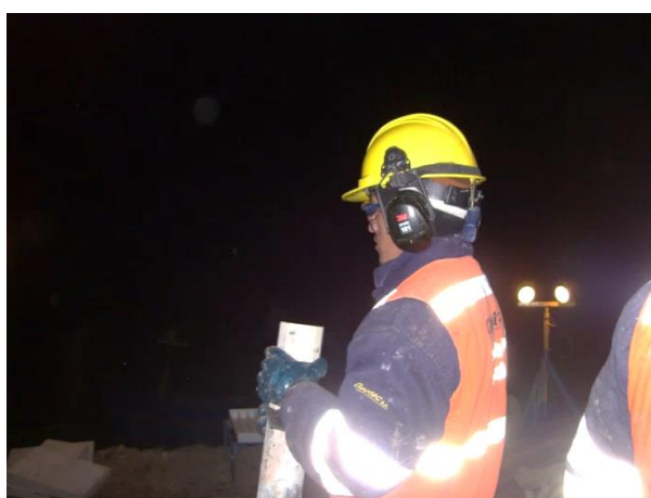
Figura 11: “Incidente con broca serrucho N° 2”
