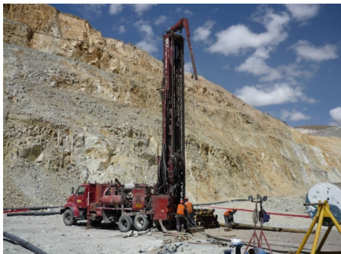
Figura 03: "Perforación de Pozo de Agua - Máquina Schramm
