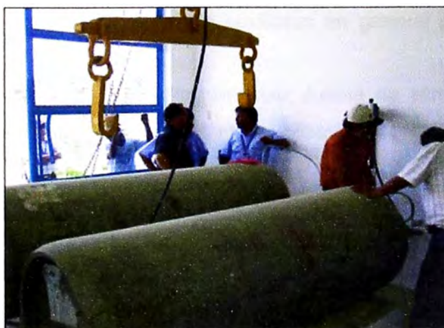
Figura 3.4 Tanque de gas cloro (Fuente: Propia)
