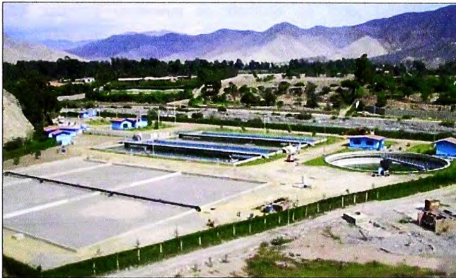
Figura 1.3 La planta de tratamiento San Antonio de Carapongo (Fuente: Propia)
