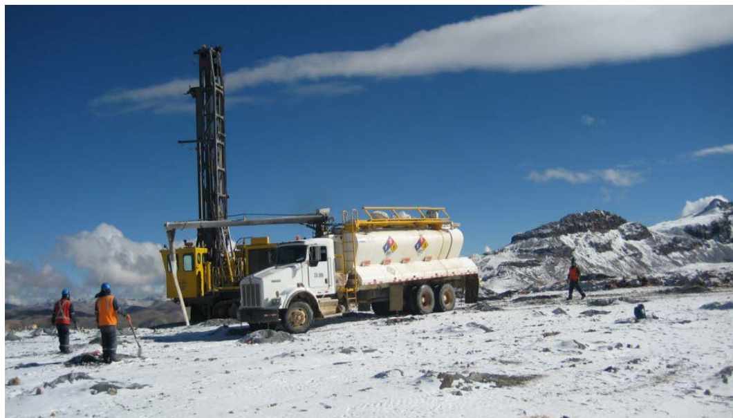
Figura 04. Carguío de los taladros con ANFO, usando camión fábrica. (Fuente propia)
