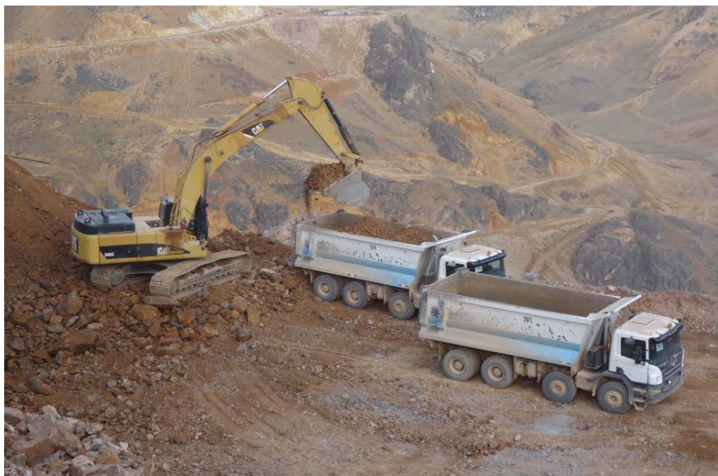
Figura 14. Excavadora 345 en frente de carguío reducido. (Fuente propia)
