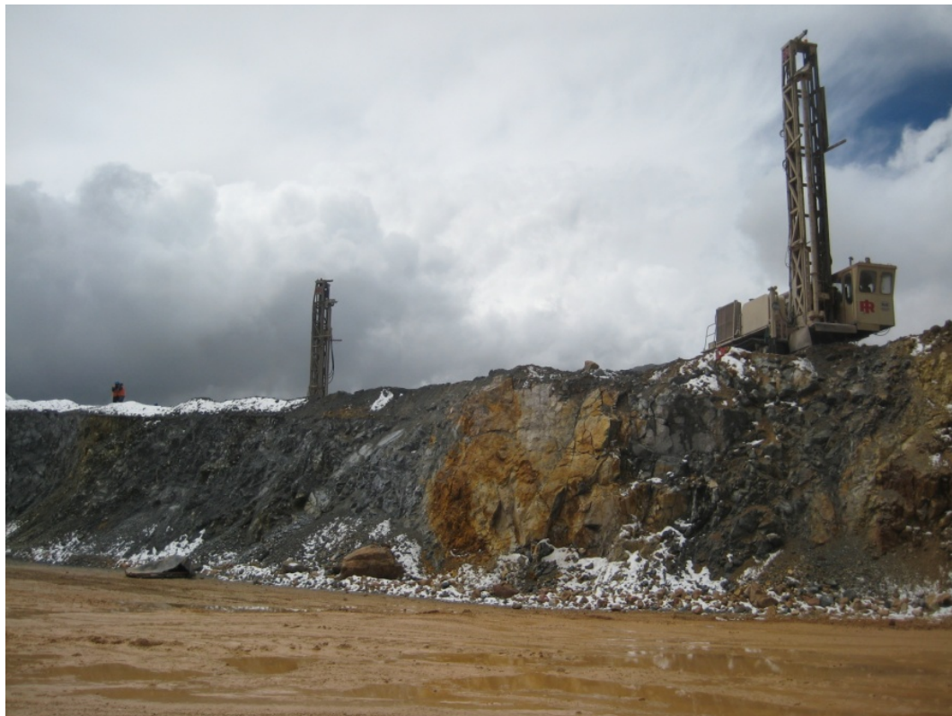
Figura 03. Perforadoras DM45 realizando perforaciones en banco de 8m sobre material desmonte. (Fuente Propia)
