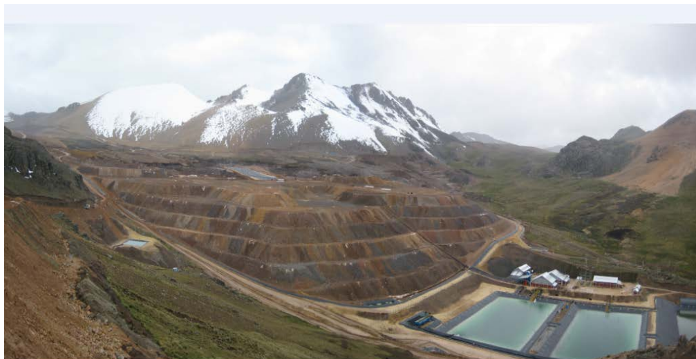
Figura 19. Vista panorámica del PAD, las pozas y la planta Merrill Crowe (Fuente propia)
