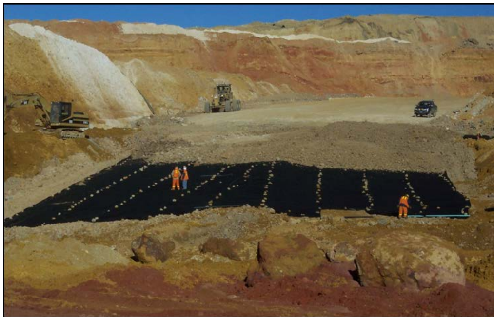
Figura 2.8 – Instalación de geotextil en vías de acarreo
