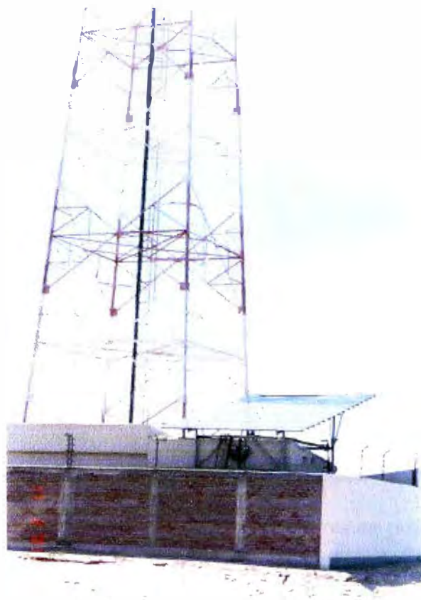
Foto B-1: ER SECHURA: Paneles Solares – Vista delantera
