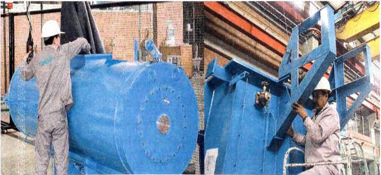
Figura 5.19 Preparación Tanque de expansión y soportes (Fuente: Instructivo SIEMENS Colombia, Servicio Técnico SAT/MA106.2 Transformadores de Potencia)
