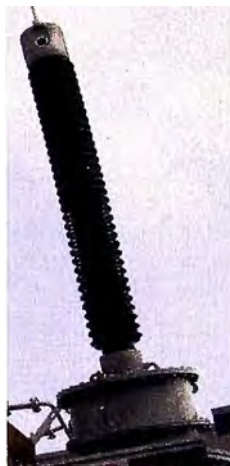
Figura 2.8 Pasatapa Tipo Condensador (Fuente: Presentación PPT Transformadores de Potencia – SIEMENS-1999 )
