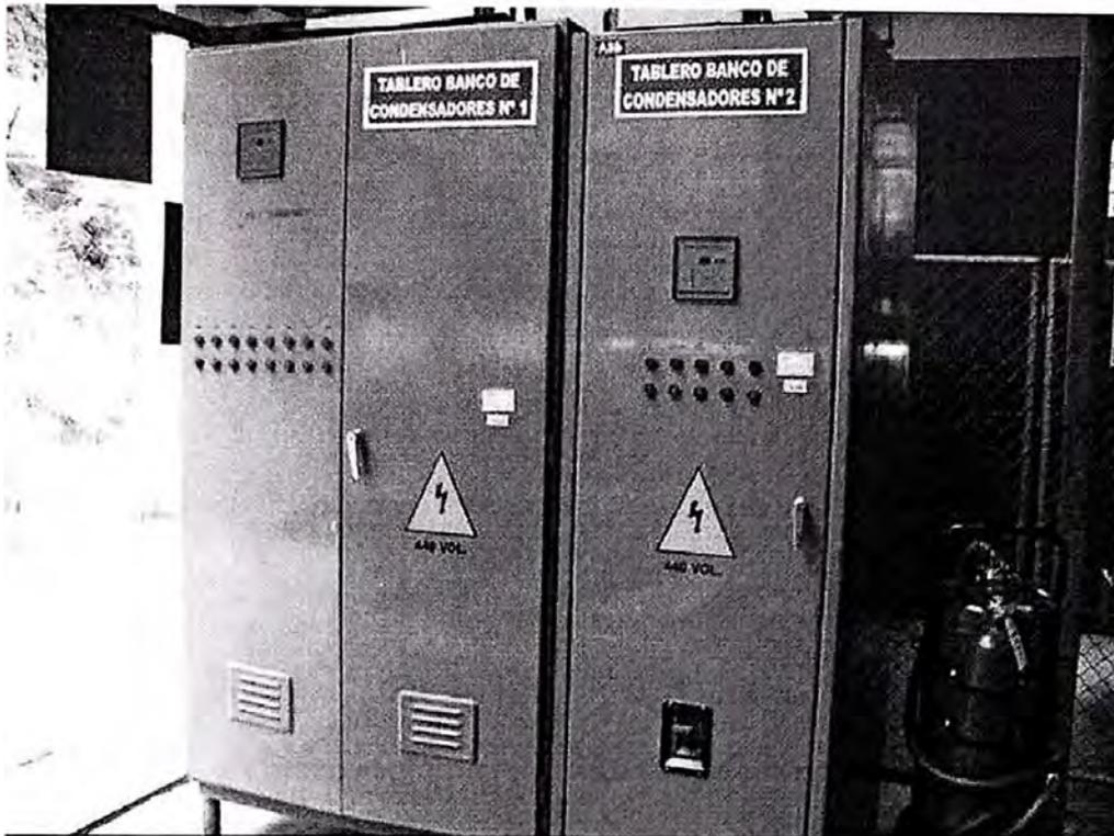
Foto No. 01 Bancos en la Central de Generación de Energía
