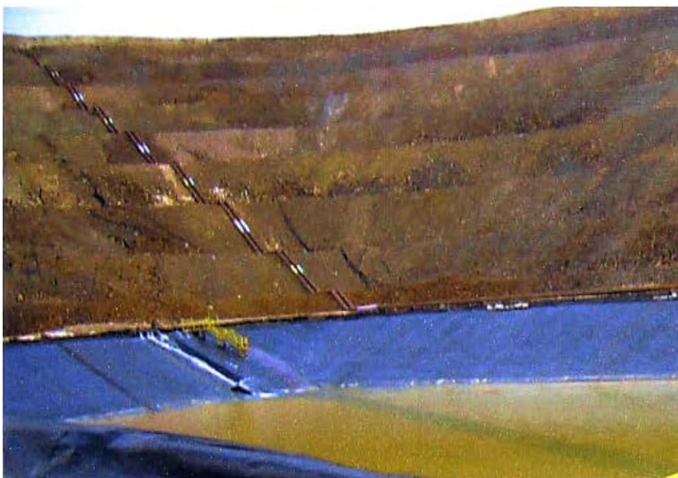
**Fig.1.10** PAD de Lixiviación y poza con solución rica
