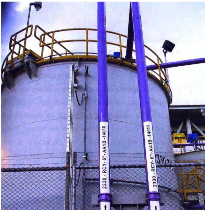
Fig.4.18 Transmisor de Nivel Magnético montado en Tanque.
