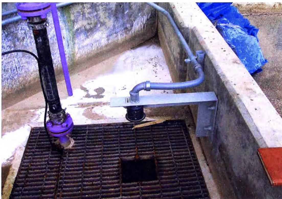
**Fig.4.21** Sensor de Nivel por Ultrasonido
