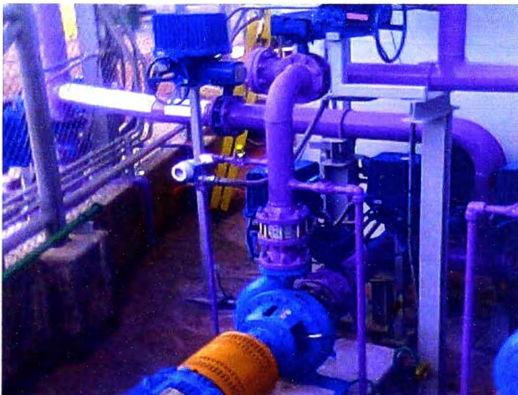
Fig.4.19 Transmisor de Presión a la salida de Bomba, con válvula de bloqueo
