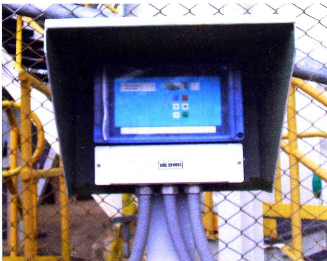
**Fig.4.22** Transmisor de Nivel Ultrasonico
