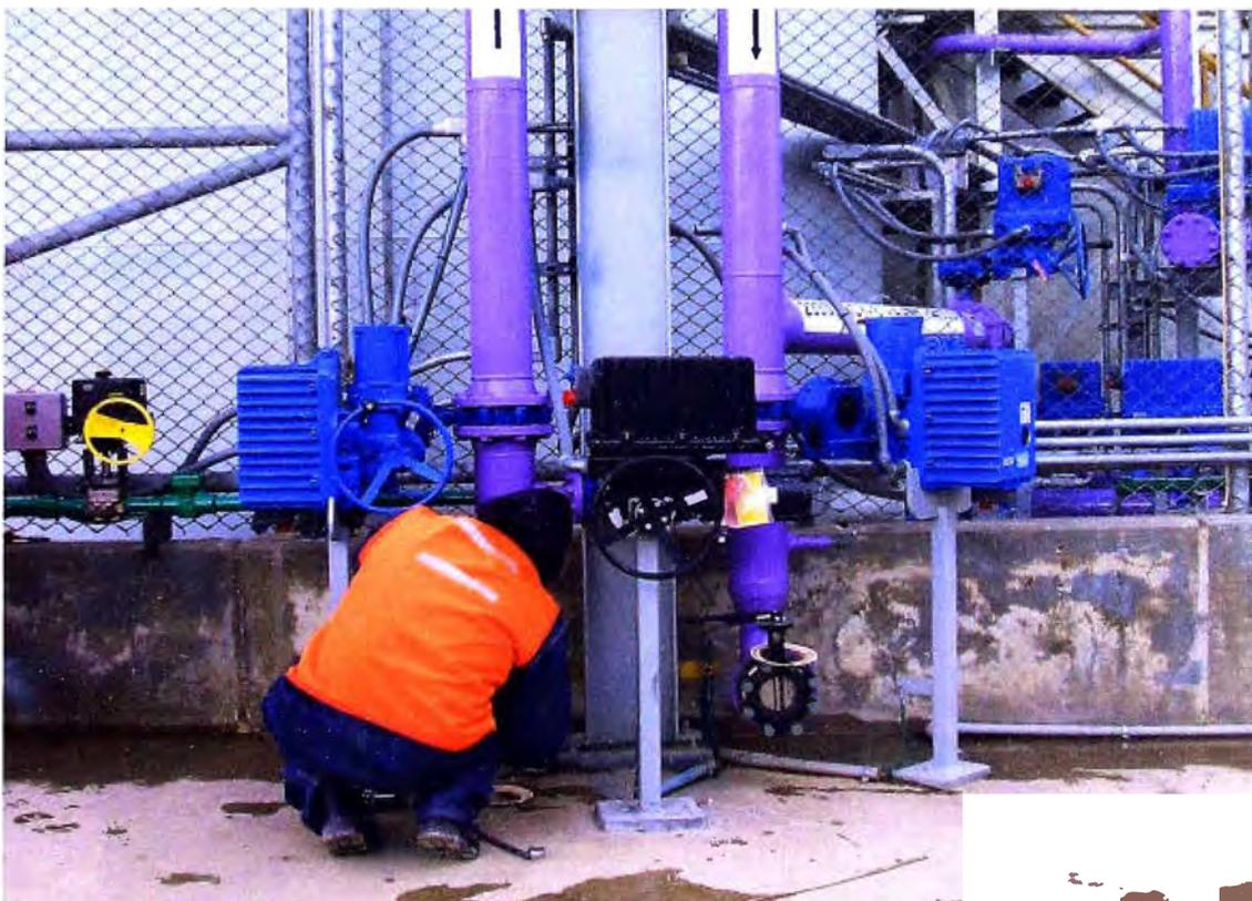
**Fig.7.3** Verificación de apertura/cierre de válvula de control motorizada
