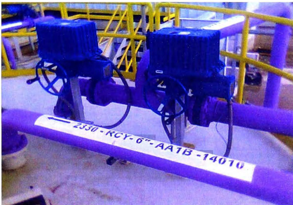
**Fig.4.28** Válvula de Control Motorizado tipo Mariposa
