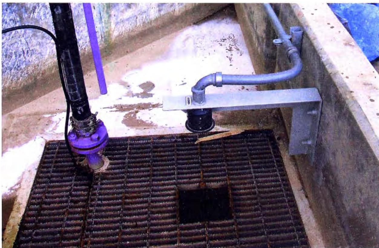
**Fig.7.15** Bomba Sumidero y sensor de nivel
