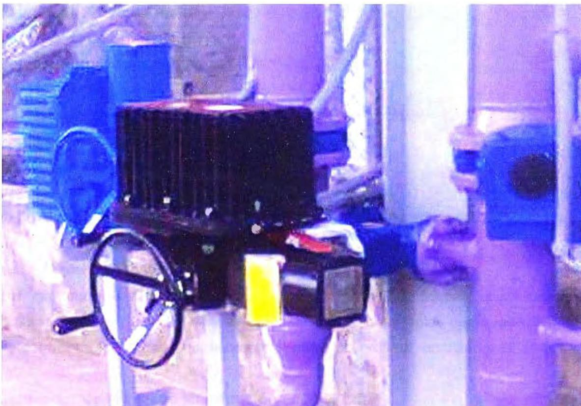
**Fig.4.27** Válvula de Control Motorizado tipo Globo
