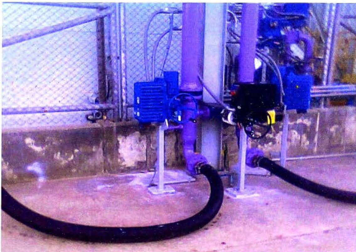
**Fig.7.6** Acoplado de cisterna con mangueras.
